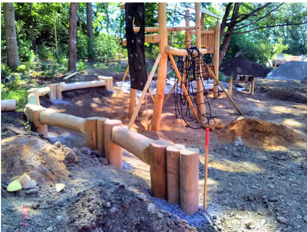
Robiniasargen på väg upp – rundstock som följer terrängen.
