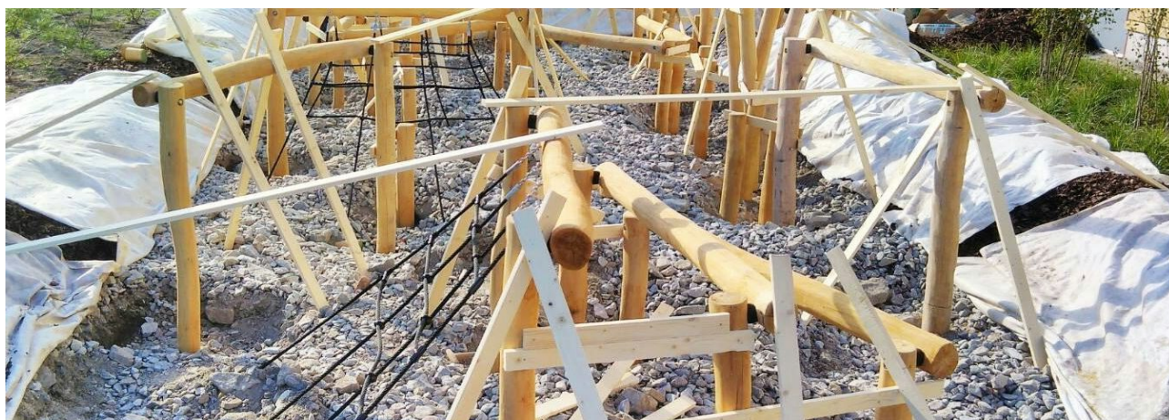
Robiniastolpar under montage i dränerande förläggning — markzonen avgör livslängden. Foto: Readymade Woods.
