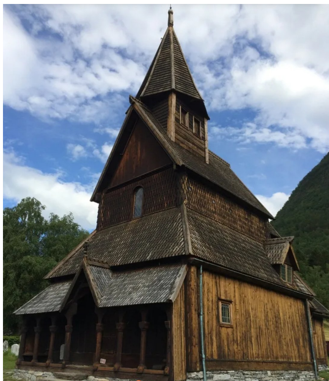
Urnes stavkyrka, Norge (1100-tal): kärnfuru, tjära, syllstenar och breda takfötter.
