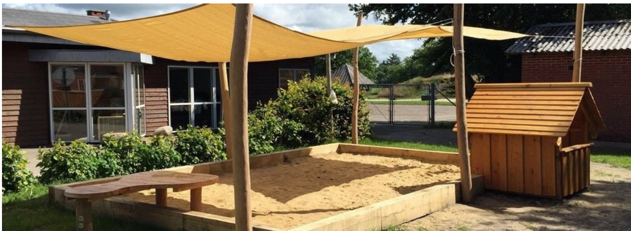
Sandlåda med sarg av ekslipers, stolpar i robinia, lekstuga med tak i douglasgran.
