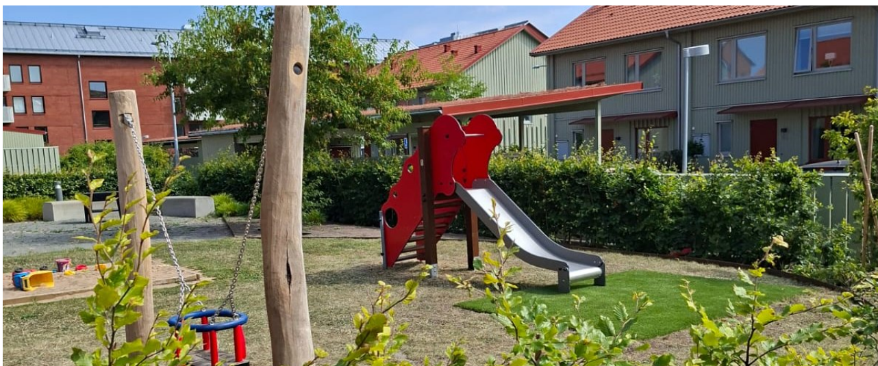
Materialen i samspel: gungstolpar i robinia, rutschenhet med sidor i HDPE och glidyta i rostfritt stål.
