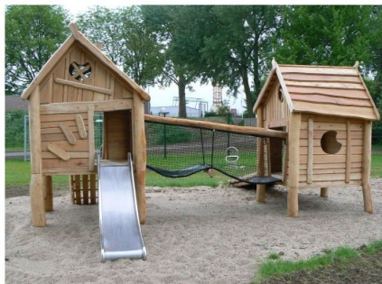
Lekhus i massivt trä — rundvirkesstolpar i robinia, panel och takdetaljer i douglasgran.
