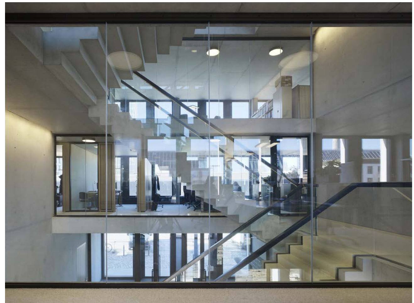
Das gläserne Atrium dient nicht nur dem Etagenwechsel der Mitarbeitenden, sondern ersetzt auch platzraubende Abluftschächte.
