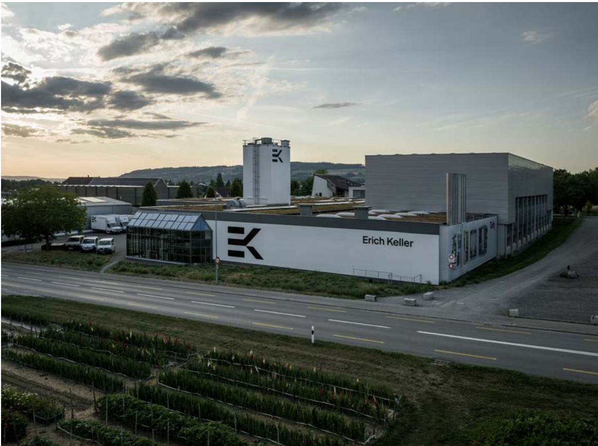
Bewährtes Gebäude, neues Logo: der Hauptsitz von Erich Keller in Sulgen. Foto: Kevin Blanc
