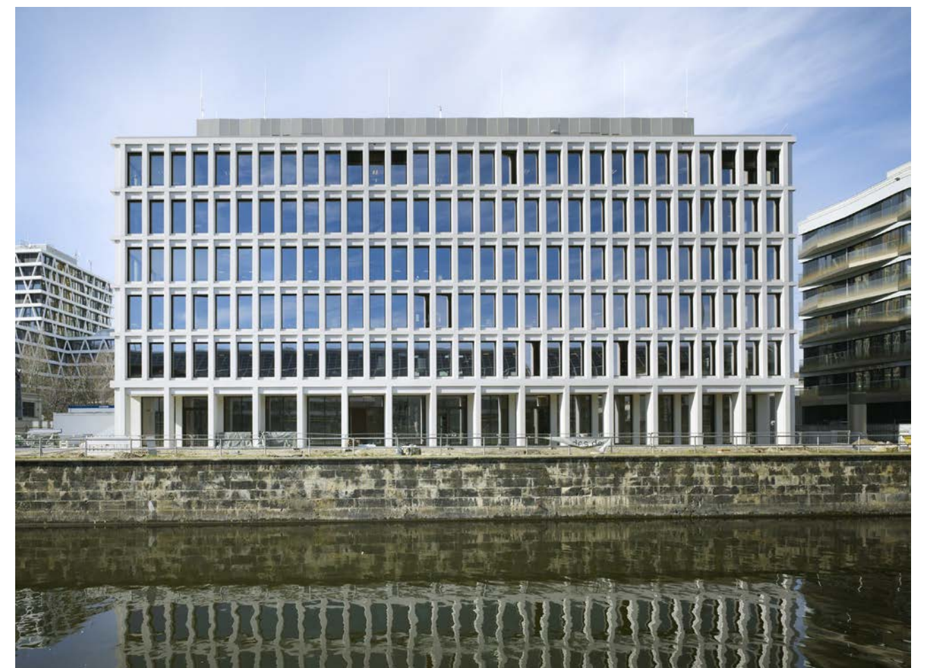
Die Betonfassade wurde vor Ort gegossen. Die Tiefe des Rasters sorgt für Sonnenschutz.
