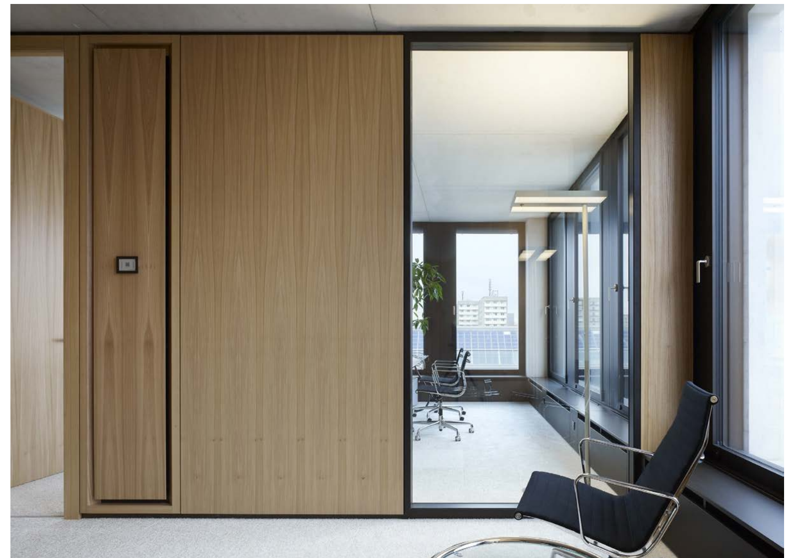
Der Beton der Decke liegt offen, in den Brüstungen arbeiten die Raumklimageräte.
