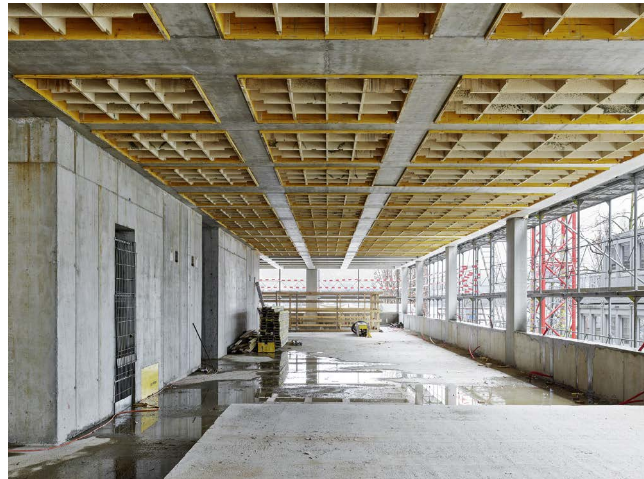
Durch ihre grössere Oberfläche sorgt die Rippendecke für viel Speichermasse. Foto: Georg Aerni
