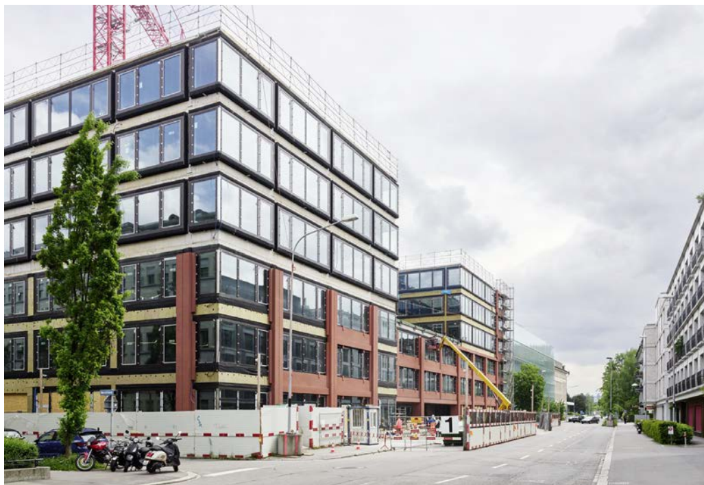
Das Gebäude «Swiss Re Lake» im Bau, hier die vom See abgewandte Seite. Foto: Georg Aerni
