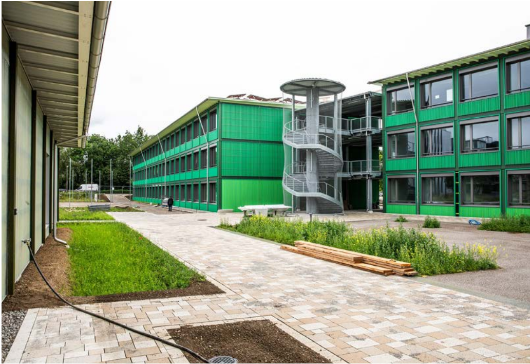
Die vorgefertigten Module können in Dübendorf demontiert und andernorts wieder aufgebaut werden.
