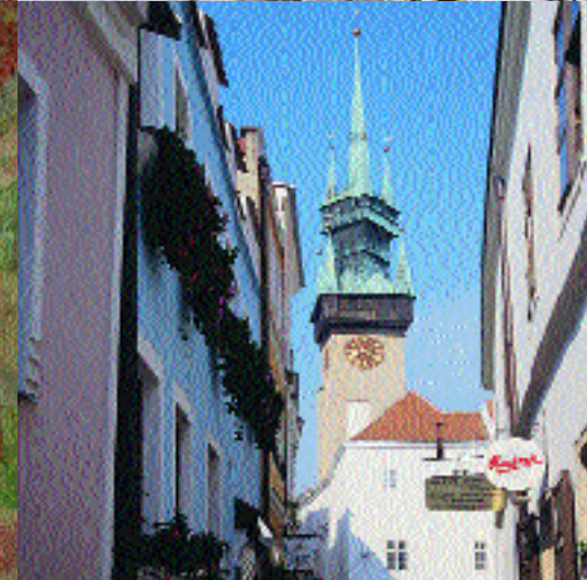
Sgraffita figuralne na froncie budynku ul. Obroková Wieża ratusza - widok od ul. Kramářskiej
