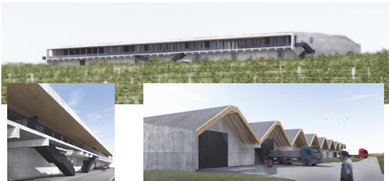
Vlnářský dům LAHOFER, Tomáš Javorský III.roč. Cena: Stavba Jihomoravského kraje 2014 v kategorii výrobní stavby – studentské projekty
