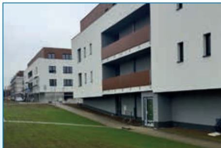
Bytové domy Kunštát
