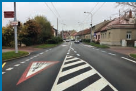
Tuřany - rekonstrukce kanalizace a vodovodu
