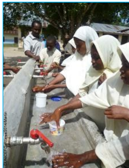
Gli scolari della scuola Jitihada beneficiano dell'acqua corrente grazie ai nuovi lavandini installati con il sostegno dell'UNICEF.
