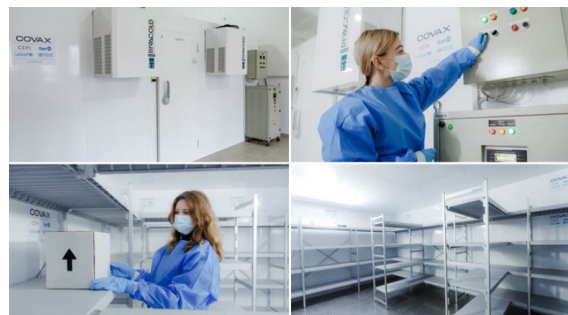
2023 – Per la lotta al COVID-19 nel quadro del COVAX, e per il potenziamento della catena del freddo, l'installazione dell'UNICEF di una cella frigorifera ad Uzhorod, Ucraina.
