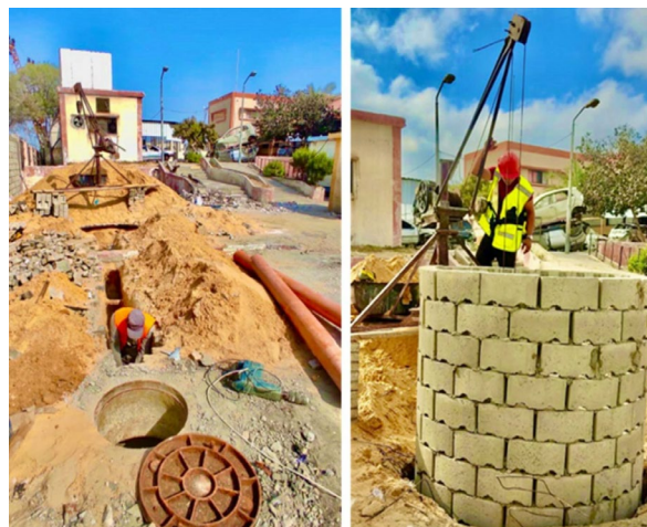
Khan Younis, giugno 2024. La costruzione sostenuta dall'UNICEF di 4 fosse settiche presso l'ospedale Nasser di Khan Younis, per contrastare la tracimazione delle acque reflue. UNICEF-SoP/2024
