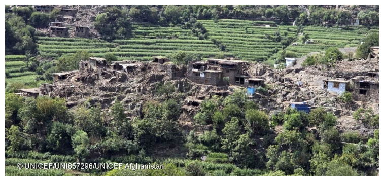
Kunar, 2 settembre. Case distrutte dal potente terremoto che ha colpito l'est dell'Afghanistan. Si stima che più di 5.000 case siano state danneggiate
