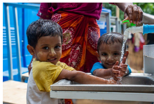
Mandalay, giugno 2025. Le stazioni per il lavaggio delle mani fornite dall'UNICEF nella regione di Mandalay, parte dei servizi idrici e igienico-sanitari installati nelle comunità per l'accesso all'acqua potabile e la prevenzione di epidemie veicolate da acqua contaminata
