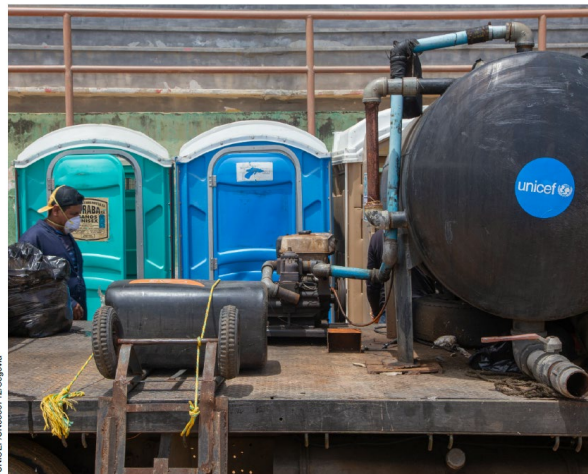
Stato di La Guaira, Venezuela, 5 luglio 2026. Le operazioni sostenute dall'UNICEF per lo smaltimento dei rifiuti fognari, l'istallazione di servizi igienico-sanitari e la clorazione dell'acqua nei 3 campi sfollati di La Guaria, parte degli interventi d'emergenza dell'UNICEF per Acqua e Igiene.
