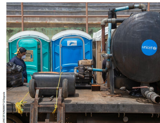
Stato di La Guaira, Venezuela, 5 luglio 2026. Le operazioni sostenute dall'UNICEF per lo smaltimento dei rifiuti fognari, l'istallazione di servizi igienico-sanitari e la clorazione dell'acqua nei 3 campi sfollati di La Guaria, parte degli interventi d'emergenza dell'UNICEF per Acqua e Igiene.
