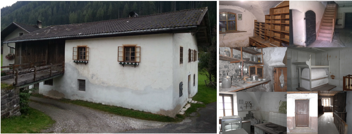
Figura 3: Maso Knablhof, prima della ristrutturazione - Alto Adige
