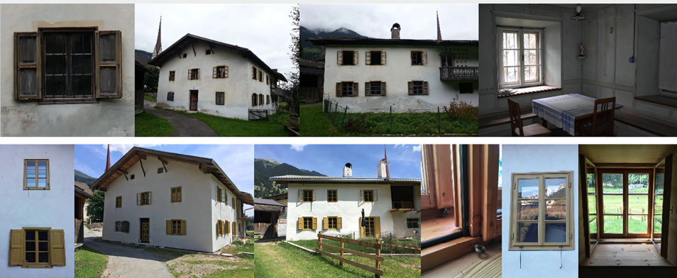
Der Knablhof in Magreit, Gemeinde Ratsching, vor und nach den Sanierungsarbeiten
