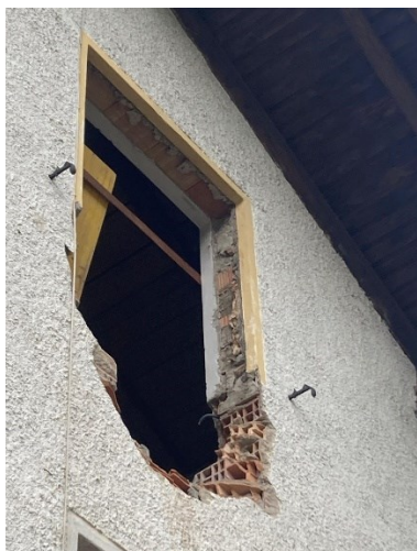
Figura 22. Muratura in laterizio forato a monostrato in un edificio degli anni '60 ad Appiano. Foto: Lara Briz
