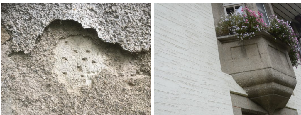
Figura 19. Sinistra: Diversi strati di intonaco sovrapposti su un maso in Val Pusteria. Destra: intonaco rigato in un palazzo in Vipiteno, tipico dello Jugendstil dei primi del '900. Foto: Lara Briz
