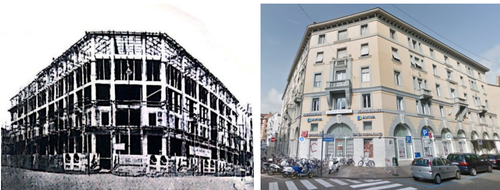
Figura 14. Costruzione in telaio di calcestruzzo di un lotto in angolo tra via Cassa di Risparmio e via Leonardo da Vinci e stato attuale. Fonte: Archivio Storico di Bolzano e Google Maps 2025
