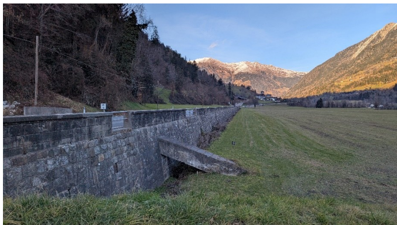
Bild 9: Stützmauer an der identifizierten Passage im Passeiertal
