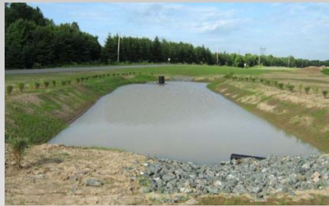
Photo 4. Bassin de rétention et de sédimentation
