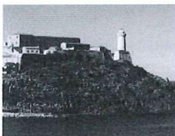
L'edificio è situato nella parte sommitale del Complesso fortificato di Forte Stella. E' esposto a tutti i venti più importanti subendone l'aggressione che innesca una forte azione di erosione e consumo, sia delle vernici applicate sia dell'intonaco sottostante rendendo più vulnerabili le murature.
