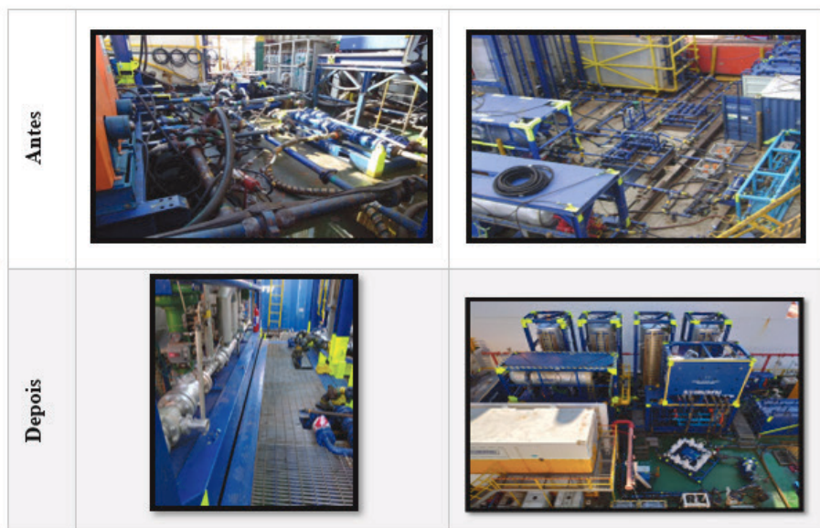
Figura 3: Antes e depois da aplicação do Lean
