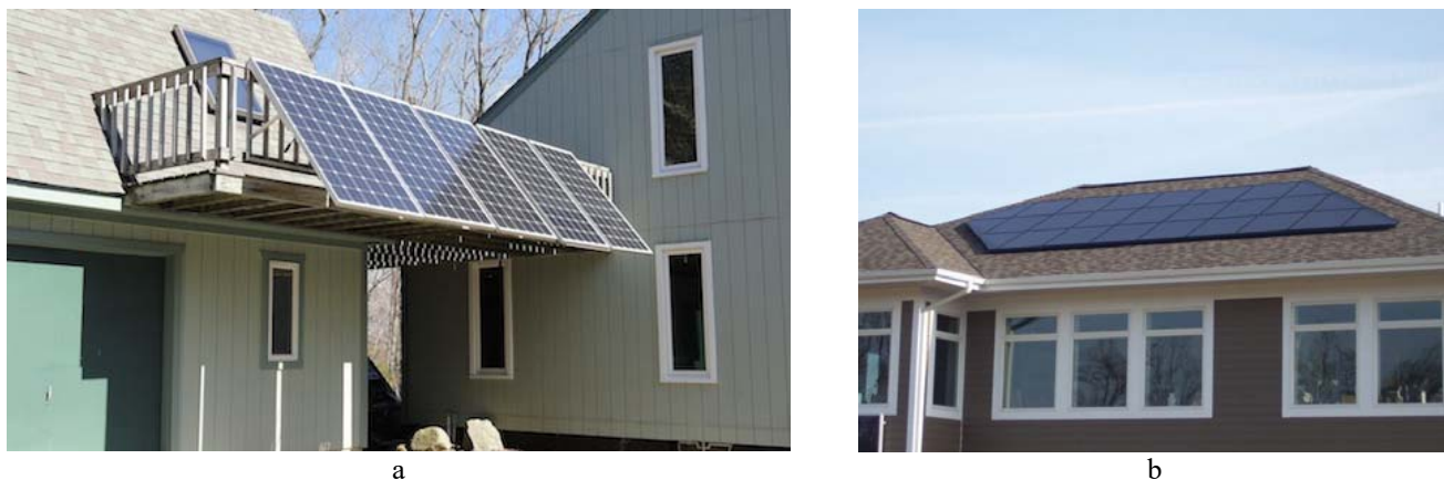
Fig. 7.13 – Esempio di impianto fotovoltaico: a) Con moduli monocristallini installati nel balcone-terrazzo – b) Con moduli policristallini.
