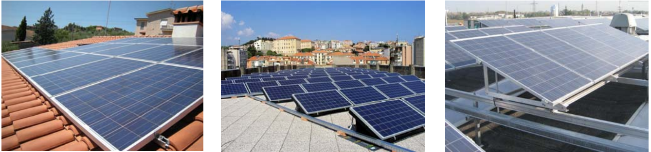
Fig. 7.22 – Esempi di impianti fotovoltaici collegati alla rete elettrica nazionale (grid-connected).
