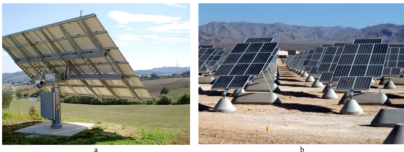
Fig. 7.39 – Esempi di strutture ad inseguimento solare: a) Per installazioni a terra – b) Campo solare.
