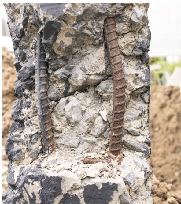
Distacco del copriferro in una struttura cementizia.
