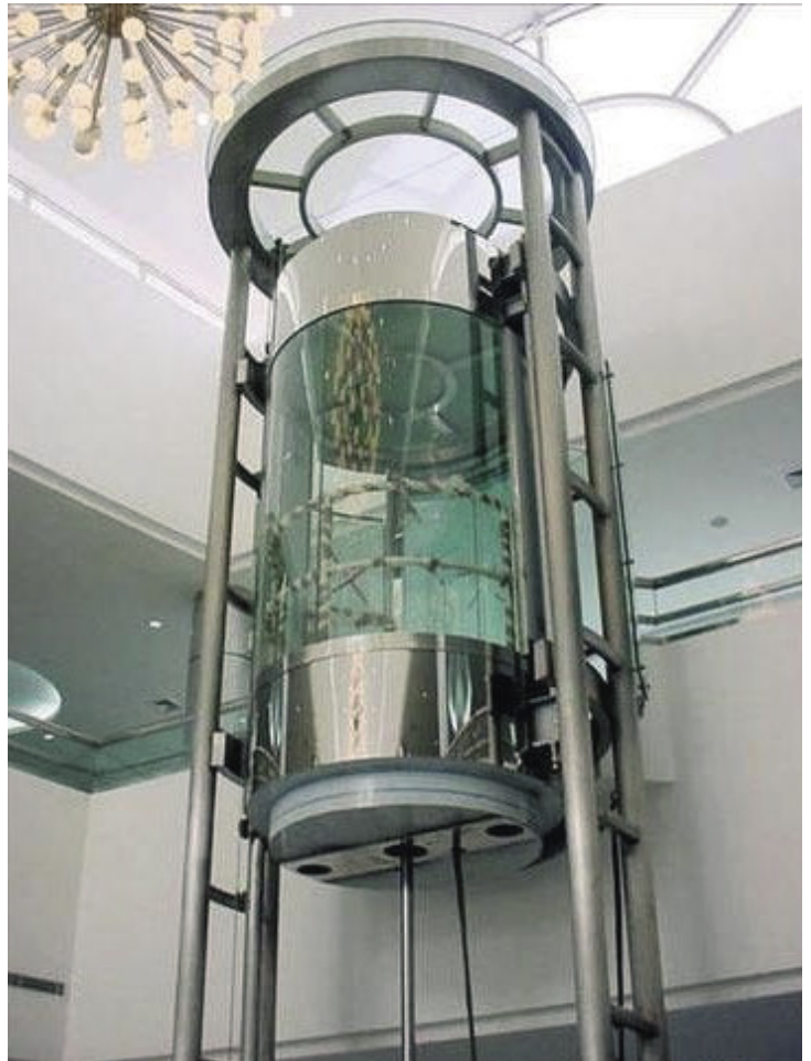
Ascensore a comando oleodinamico.
