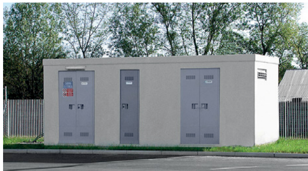
Fig. 1. Cabina in muratura (Edilceem).
