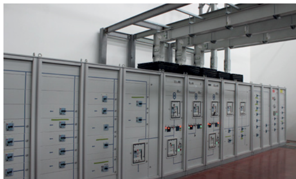
Fig. 18. Sbarre e passerelle portacavi.
