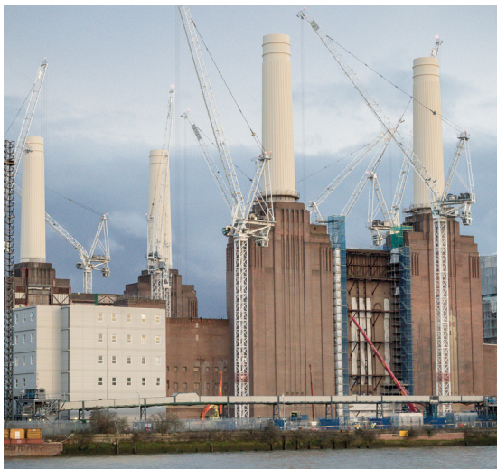
Centrale idroelettrica sul Tamigi, a Londra.
