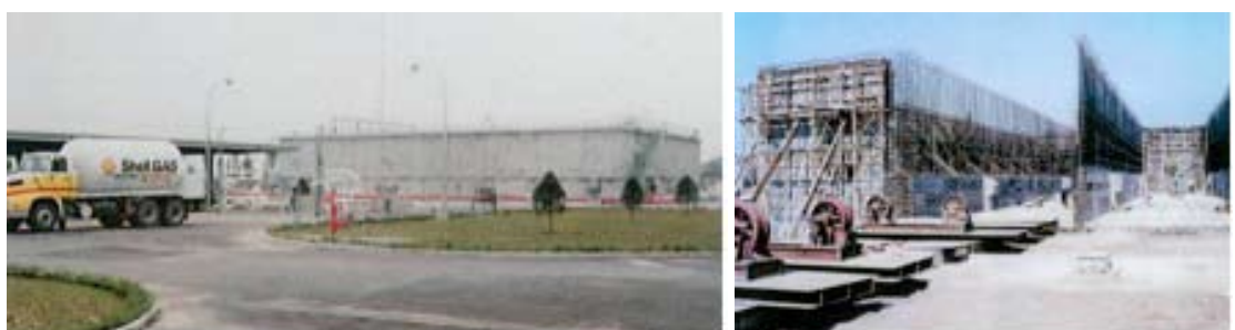
Figuur 2.1.1.4.4-2 Bouw en opstelling van het gerealiseerde 'submerged' opslagsysteem in Vietnam
