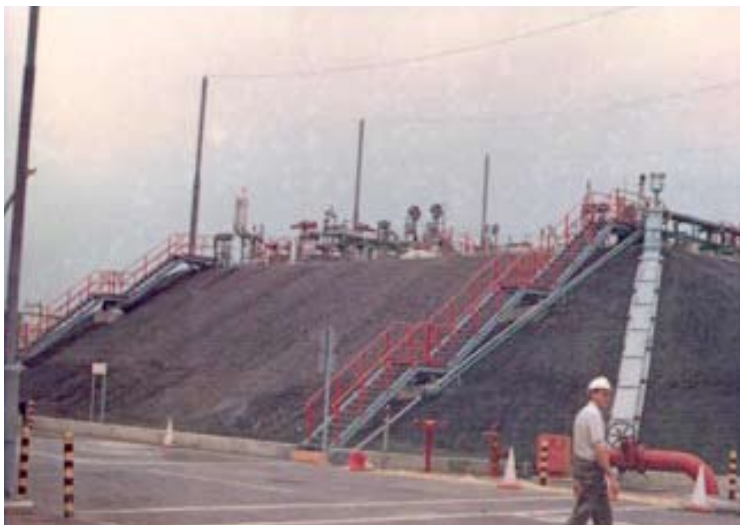
Figuur 2.1.1.4.3-1 'Mounded Storage Vessels' voor LPG
