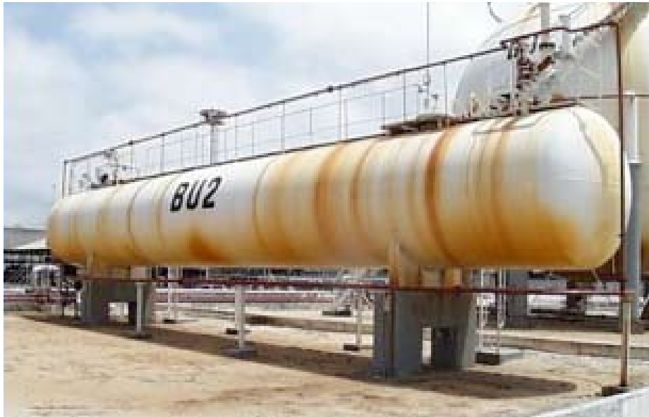
Figuur 2.1.1.4.2-1 Typische opstelling bovengronds drukvat
