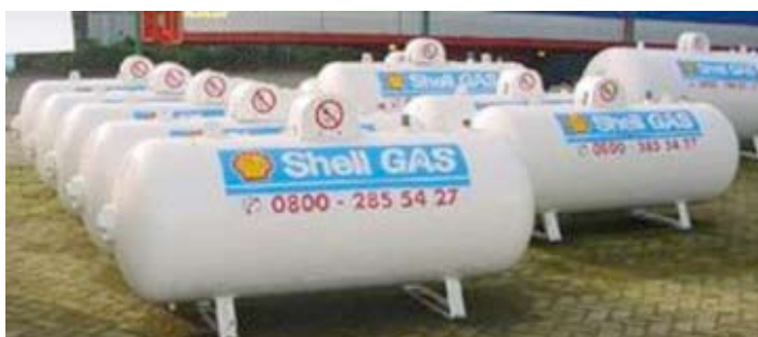
Figuur 2.1.1.4.2-2 Een horizontaal bovengronds drukvat (een veel voorkomend systeem)
