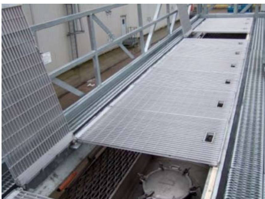
Figuur 3.5.4-1 Typische uitvoering Multi-Modal valbeveiligingsysteem
