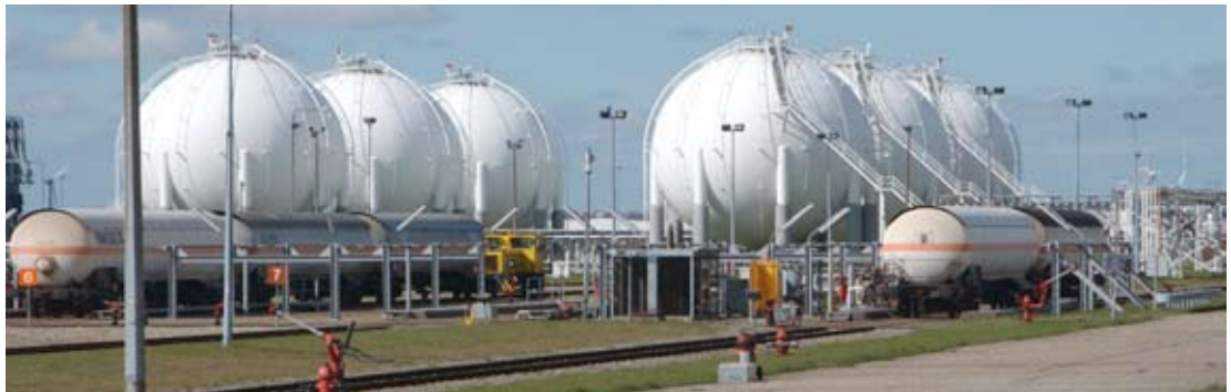
Figuur 2.1.1.3.2-1 Opstelling van bovengrondse drukopslagsystemen
