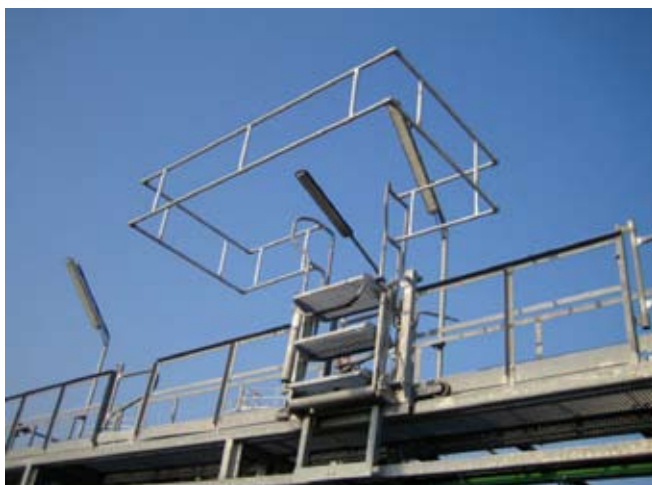
Figuur 3.5.2.1-3 Typische uitvoering verrijdbare klaptrap
