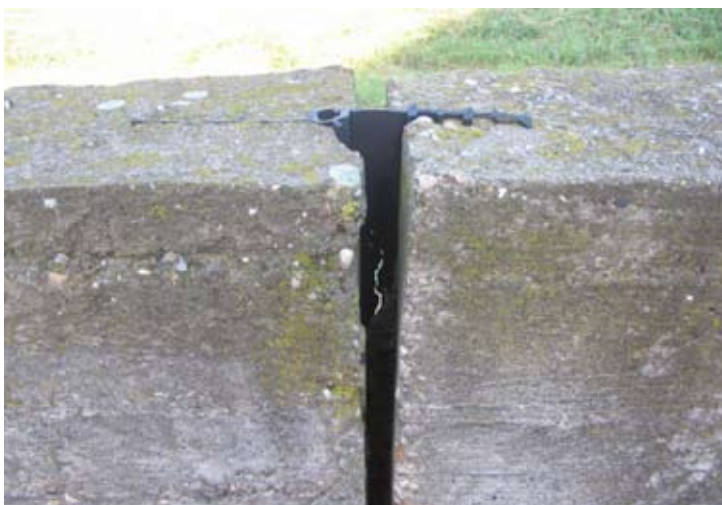
Gescheurde pakking in verbinding van betonnen putdijk
