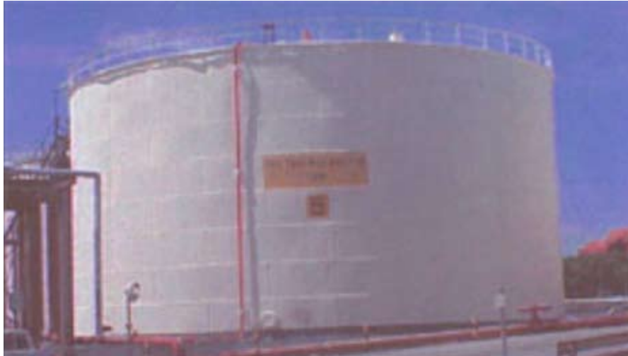
Figuur 4.4.1-1 Een tank gebouwd in 1900 en nog steeds in gebruik (Singapore)
