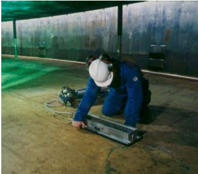
Figuur 5.3.4.4.6-2 Vacuümbox-inspectie in uitvoering
