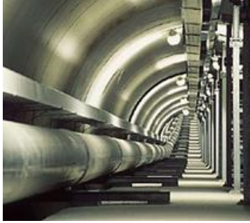
Ondergrondse straat voor het transport van gevaarlijke stoffen door buisleidingen. 73
