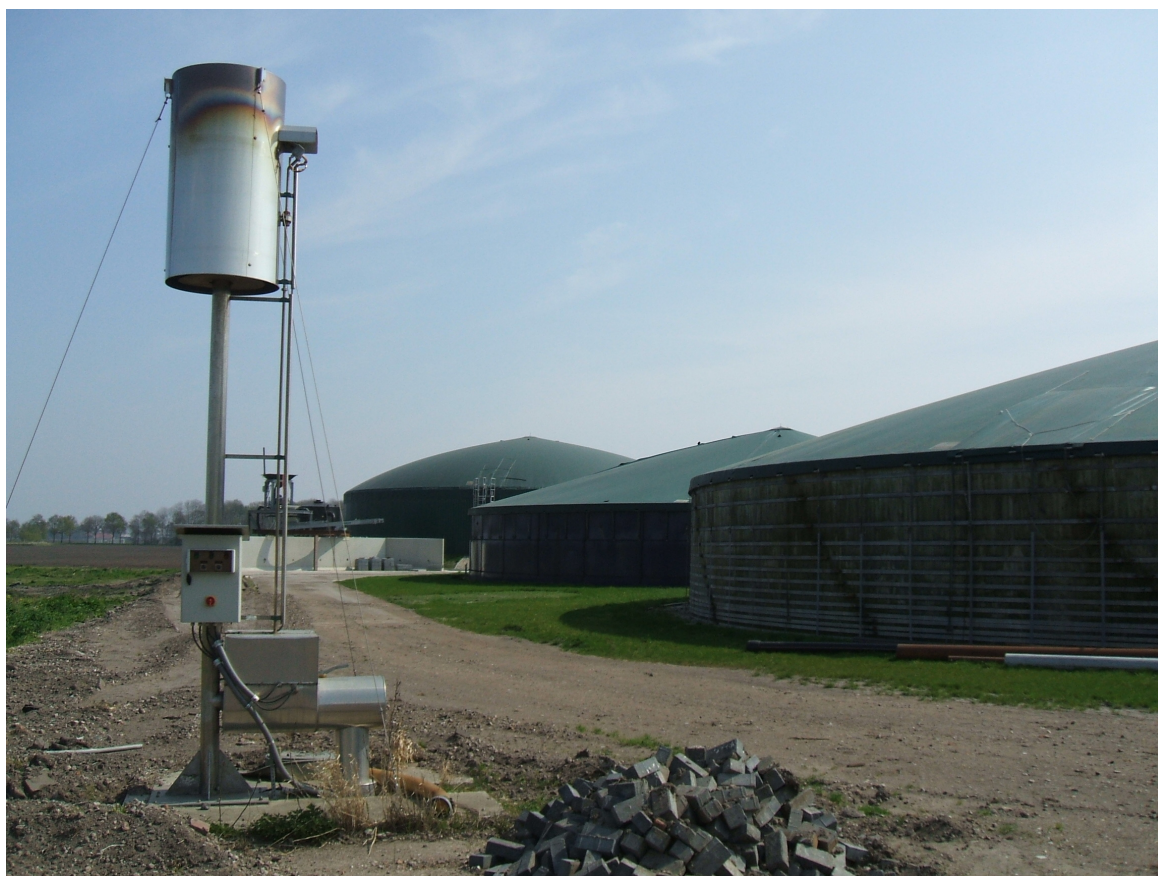
Figuur 3 Automatische fakkelinstallatie die een overschot aan biogas verbrandt welke wordt geactiveerd als de overdruk in de vergister hoger is dan 3,2 mbar (Jansen Wijhe Energy bv te Kiel-Windeweer, 17 april 2009).
