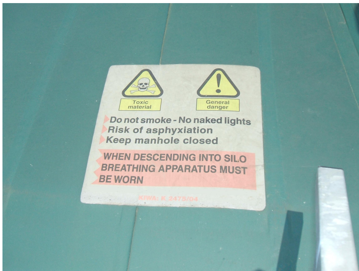
Figuur 2 Waarschuwing op het foliedoek van een vergister (Jansen Wijhe Energy bv te Kiel-Windeweer, 17 april 2009).
