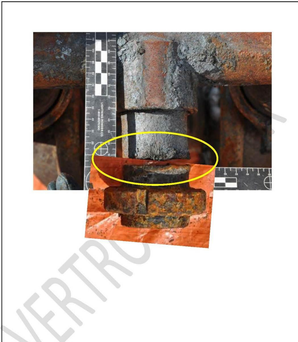
foto's: FO WMB_23-03-11_Onderzoek pomp OvV Fotobladnummer 4 Bovenaanzicht + compilatie persleiding / melkkoppeling
