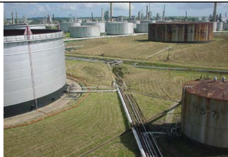
Ingevallen pijpbrug door een putdijk.
