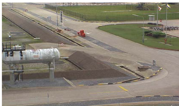
Illustratie: Trap en bordes bij damwand/ hoge putdijk (links). Toegangsrampe bij aarden/ hoge putdijk (rechts).
