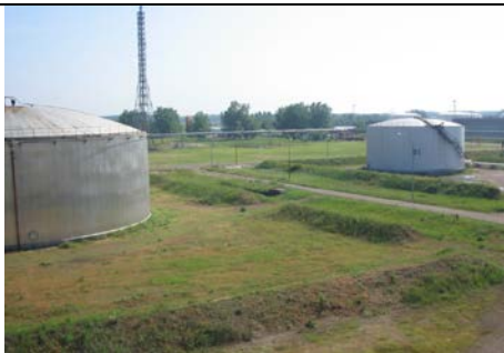
Doorgegraven putdijk niet gerepareerd na onderhoudswerk aan tanks.
