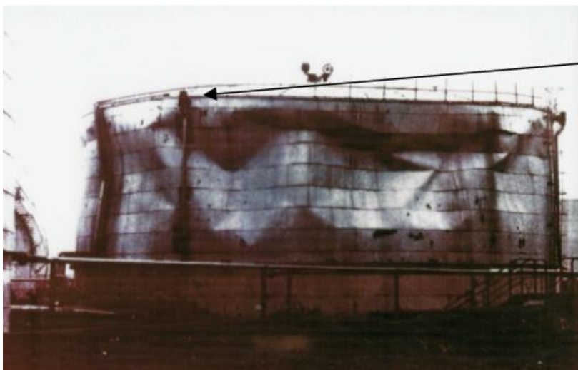
Foto 2: tank met vast dak (vervormd).
