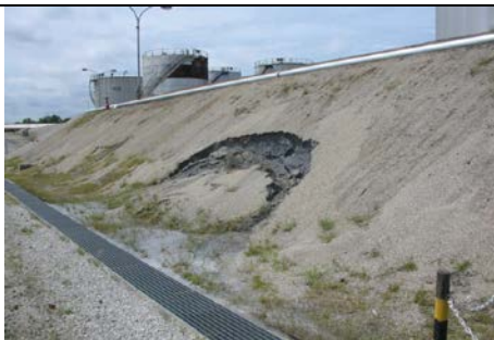
Doorgegraven putdijk niet gerepareerd na onderhoudswerk aan tanks.
