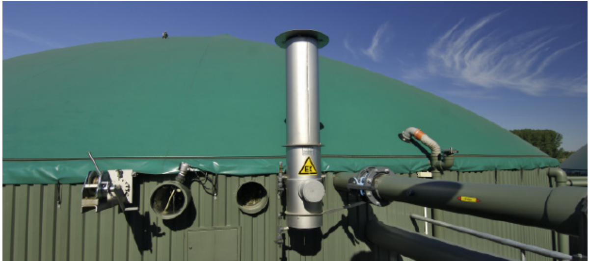
Overdruk- en onderdrukbeveiliging op een vergister
