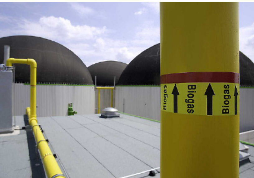
Gasleidingen (en etikettering)
