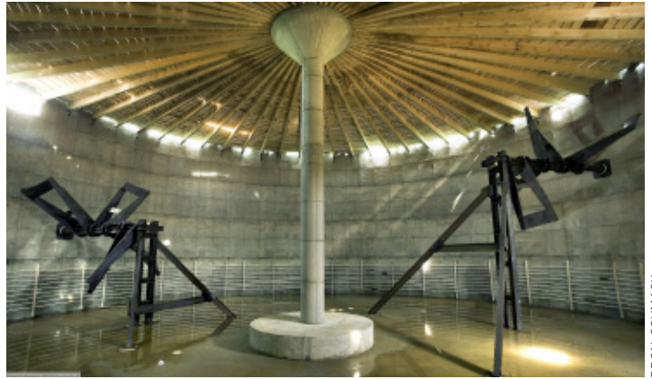
Interieur van een vergister voorafgaand aan inbedrijfstelling
