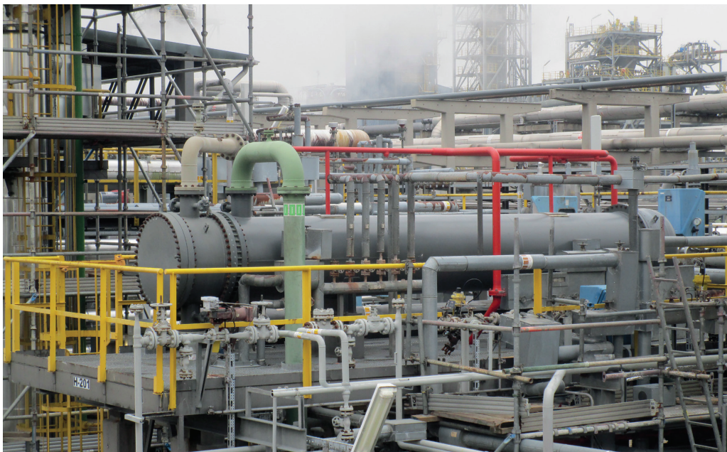
Figuur 2: Foto van de isobutaankoeler in de LDPEF-3 (Bron: SABIC)
