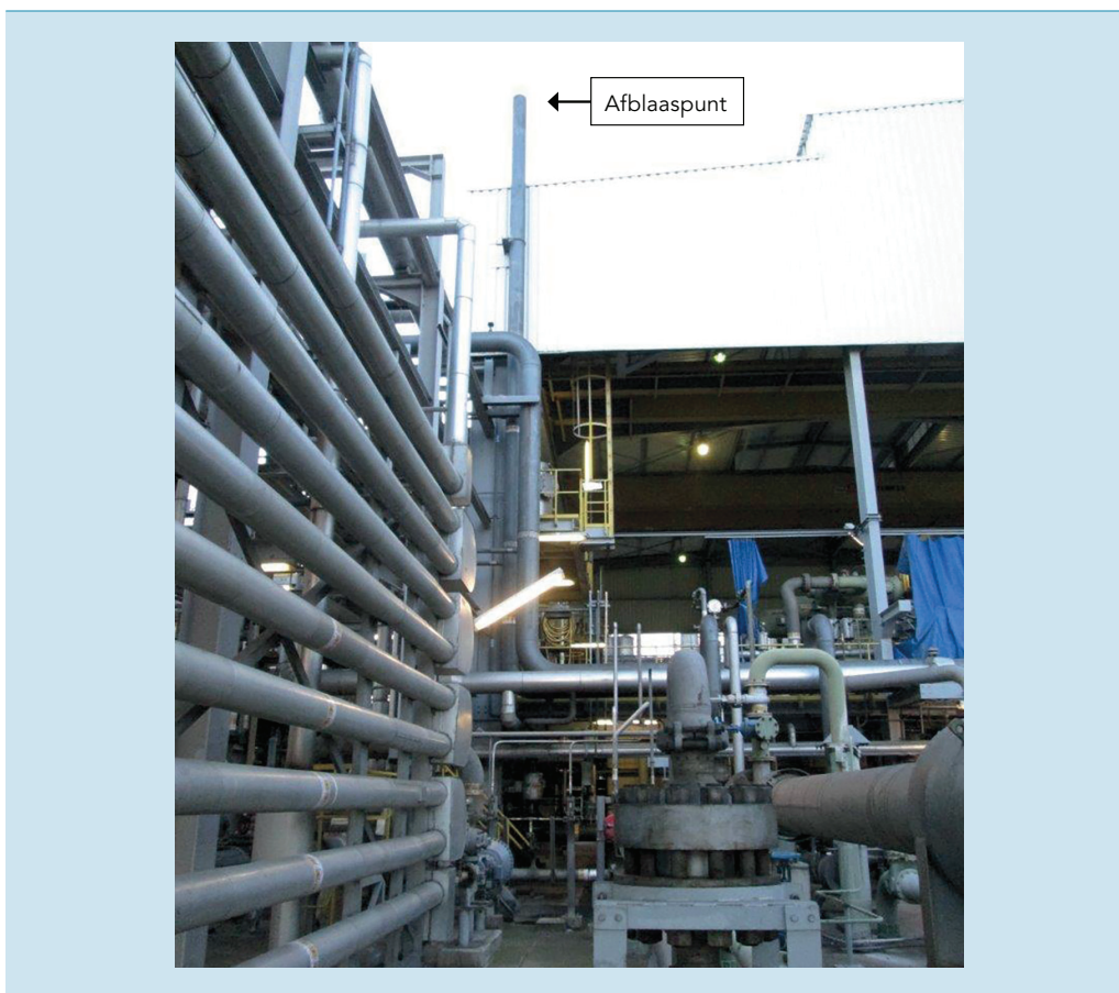
Figuur 5: Het afblaaspunt van de compressor 17K201 - aangegeven met pijl (bron: SABIC)
