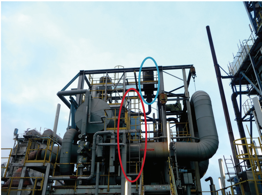
Figuur 9: Foto van zij aanzicht van de fabriek met in de rode ovaal één van de twee kooiladders naar het bordes met de afsluiters en in de blauwe ovaal de locatie van de demper. (Bron: Onderzoeksraad voor Veiligheid)
