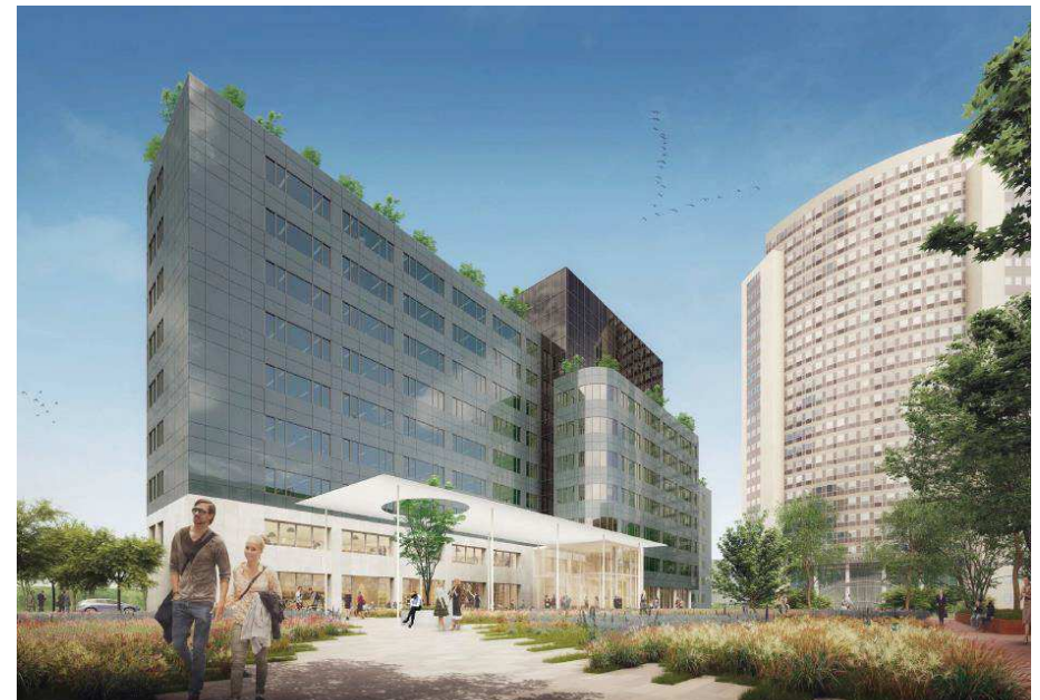
Transformatie kantoor Spark Offices, OVG, 2017
