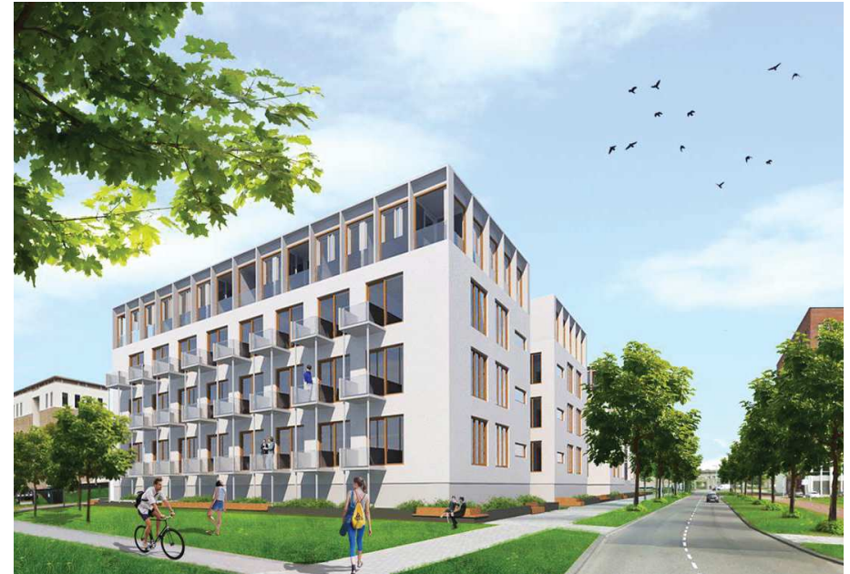
Transformatie naar wonen Woonstudio's Barajasweg, 2017
