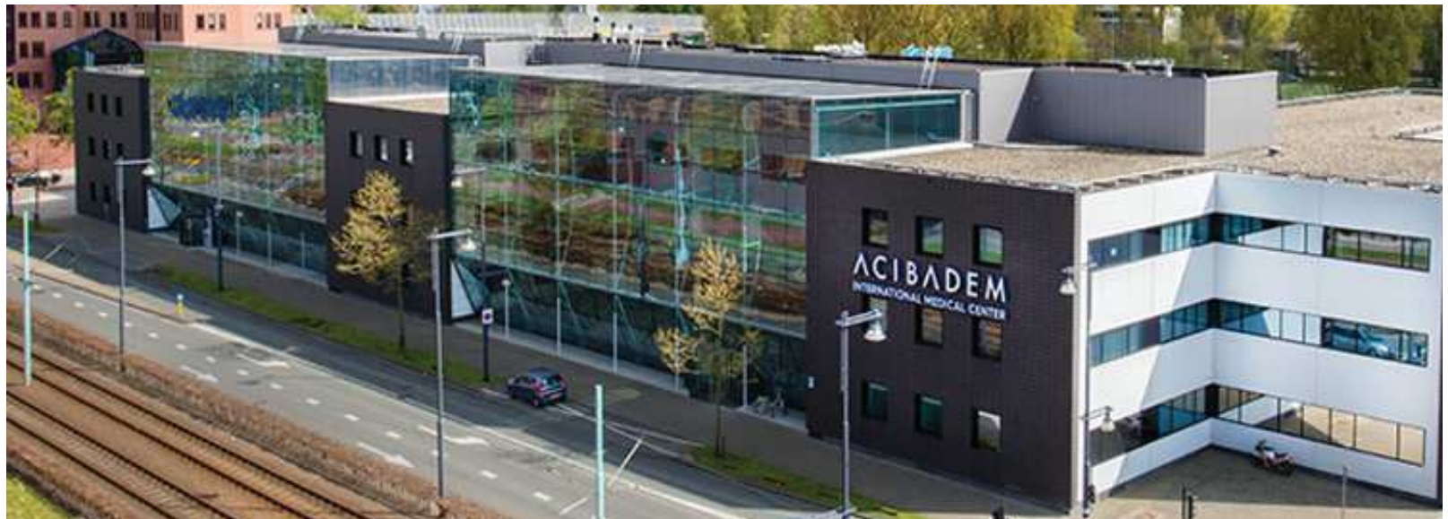
Transformatie kantoor naar zorg, Acibadem, 2016
