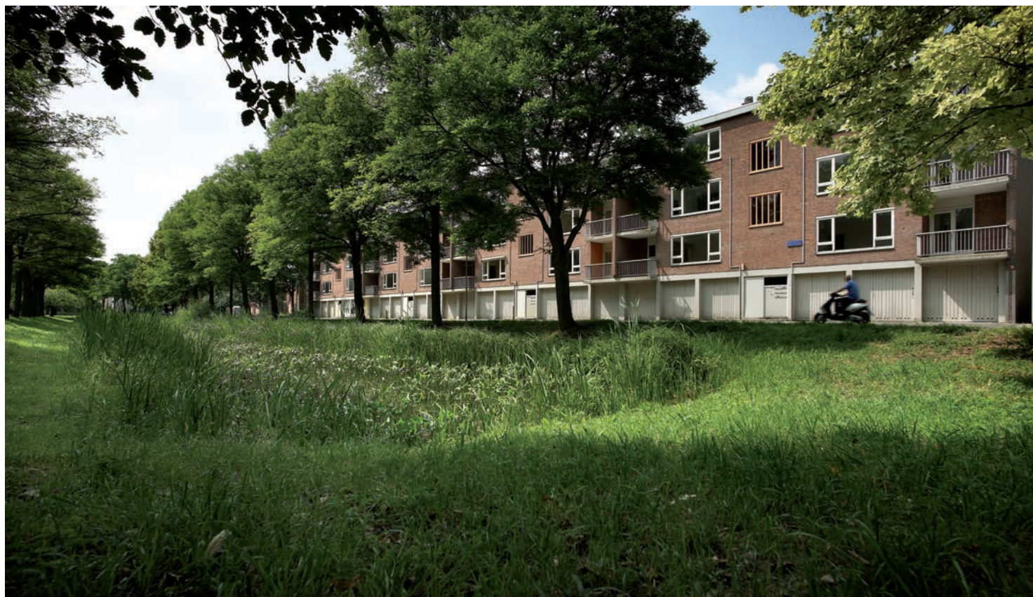
De gedeeltelijke sloop en nieuwbouw in Dieze-Oost verloopt in fases.
