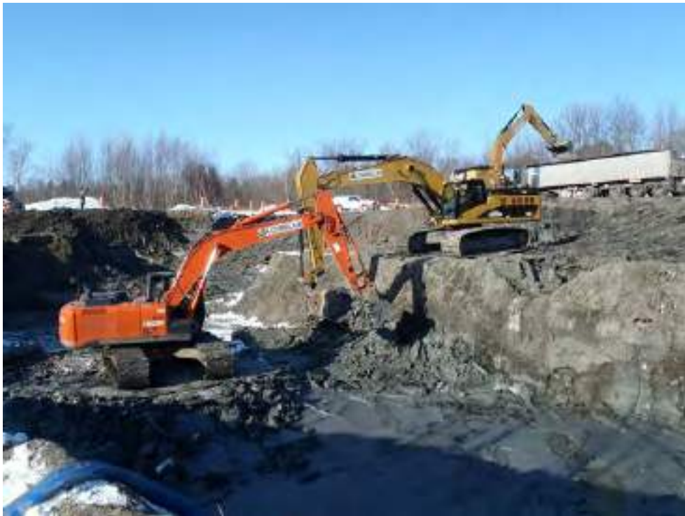
Photo 1 : Zone A - Vue vers le sud le sud de l'excavation A1.
