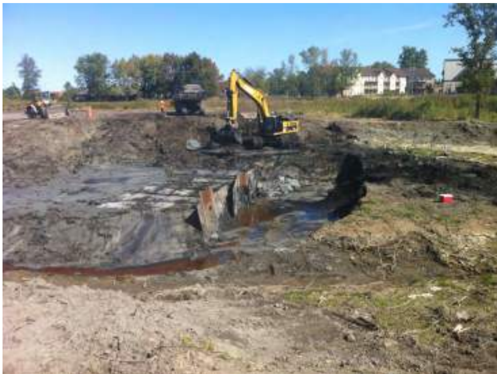
Photo 56 : Travaux de colmatage de l'extrémité aval du tronçon du ruisseau abandonné.
