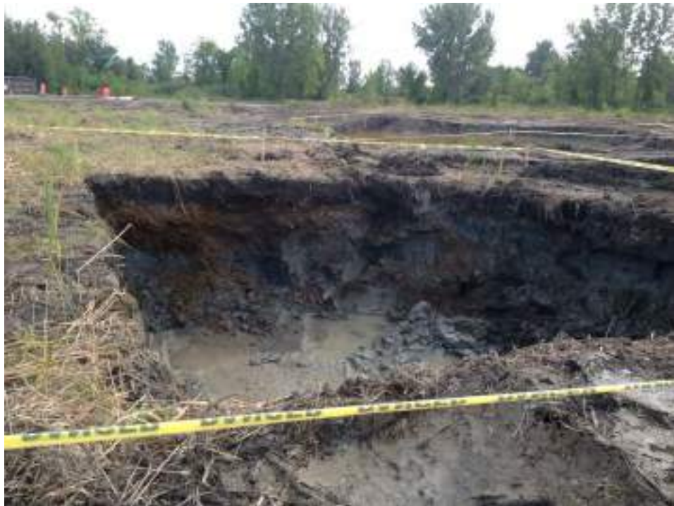
Photo 17 : Zone B - Vue vers le sud de l'excavation B8.
