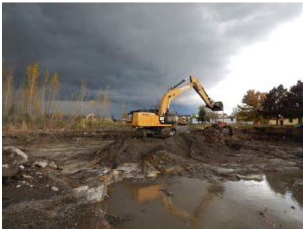
Photo 15 : Zone B – Vue vers le nord de l'excavation B6.
