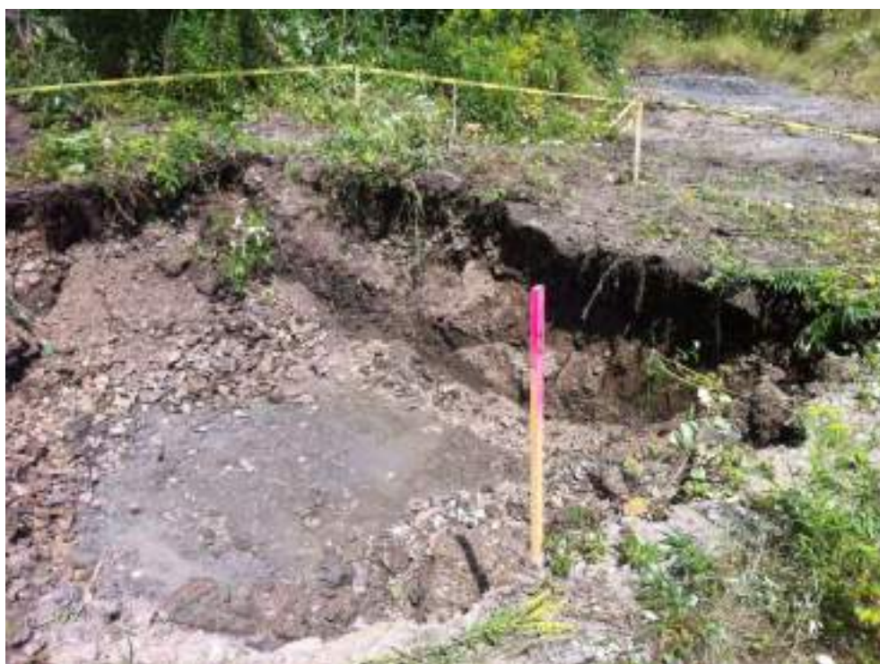
Photo 50 : Zone F - Vue vers le nord-ouest de l'excavation F4.
