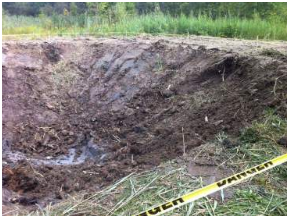
Photo 49 : Zone F - Vue vers le nord-ouest de l'excavation F3.
