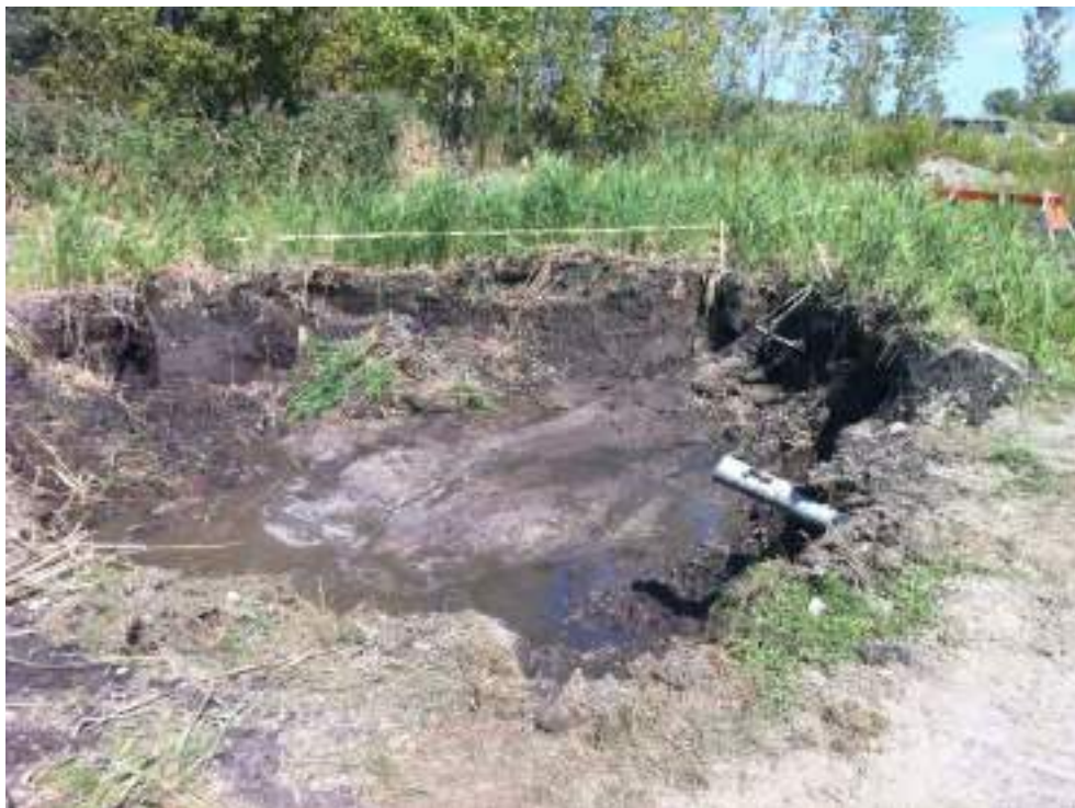
Photo 14 : Zone B - Vue de l'excavation B5.
