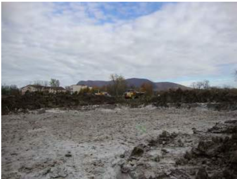
Photo 8 : Zone A - Vue de l'aire de traitement in-situ A6, une fois le mélange des sols et de la chaux complété.
