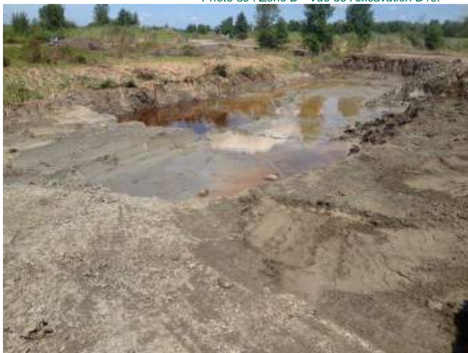
Photo 40 : Zone D - Vue vers le nord de l'excavation D11 (zone inondée) et vue aussi sur une partie de l'excavation D12.
