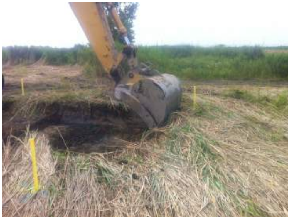
Photo 33 : Zone D - Vue de l'excavation D2.
