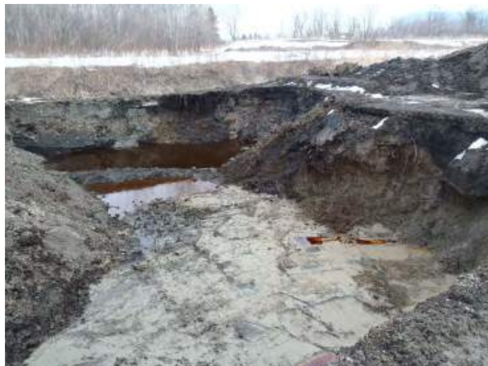
Photo 4 : Zone A - Vue vers le nord de l'excavation A3.
