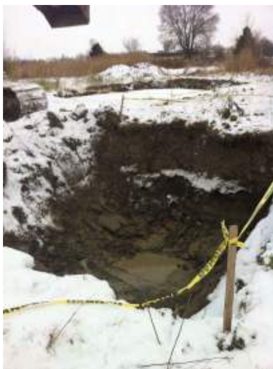
Photo 30 : Zone C14 - Vue de l'excavation C14.
