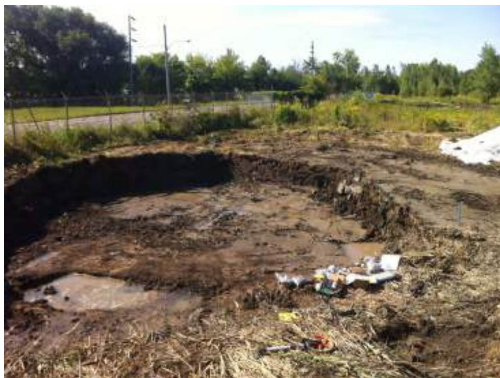
Photo 12 : Zone B - Vue vers le sud de l'excavation B3.
