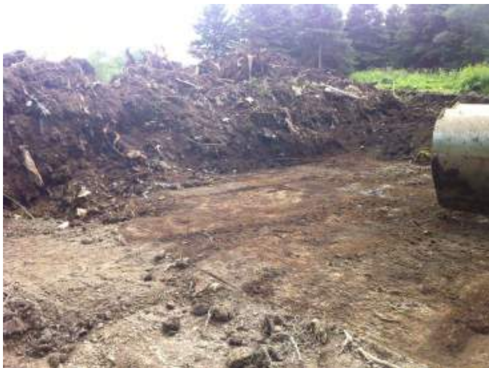
Photo 27 : Zone C – Présence de matières résiduelles dans les excavations C6-C7.
