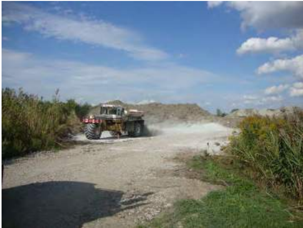
Photo 19 : Zone B - Épandage de chaux dans l'aire de traitement B10.
