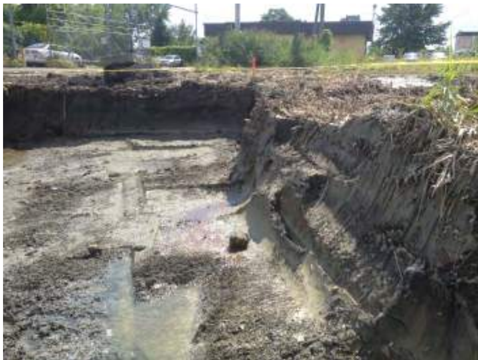
Photo 44 : Zone E - Vue vers le sud de l'excavation E1.
