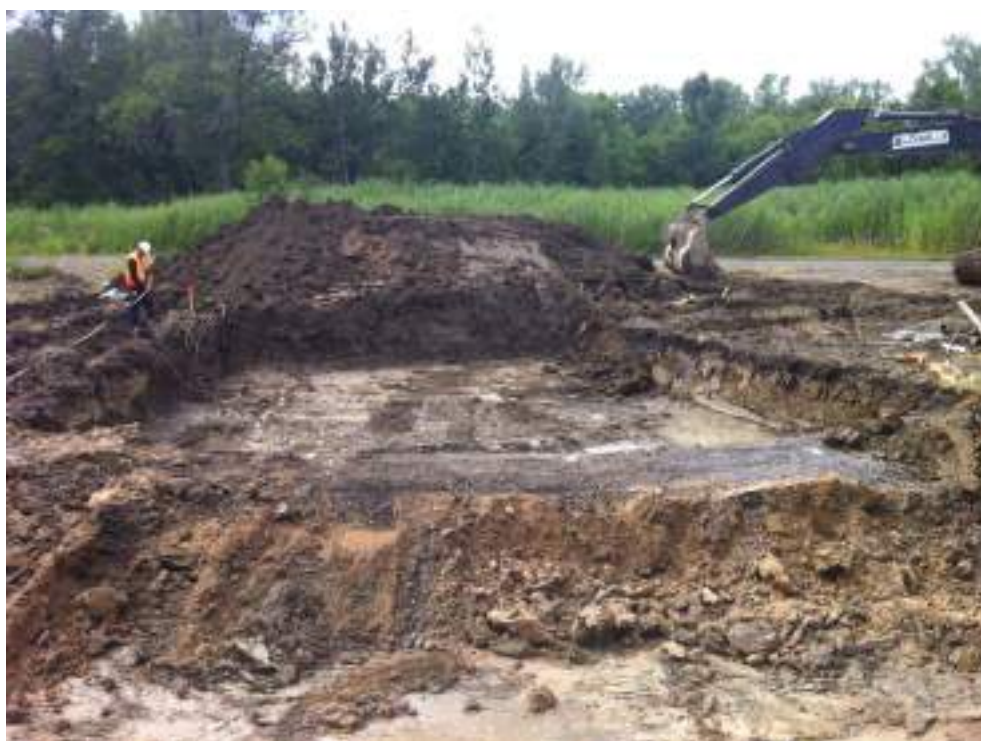
Photo 52 : Zone F - Vue vers le nord-ouest de l'excavation F2-F6-F7.
