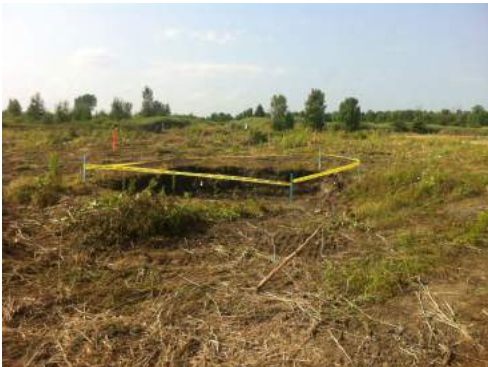
Photo 32 : Zone D - Vue de l'excavation D1.
