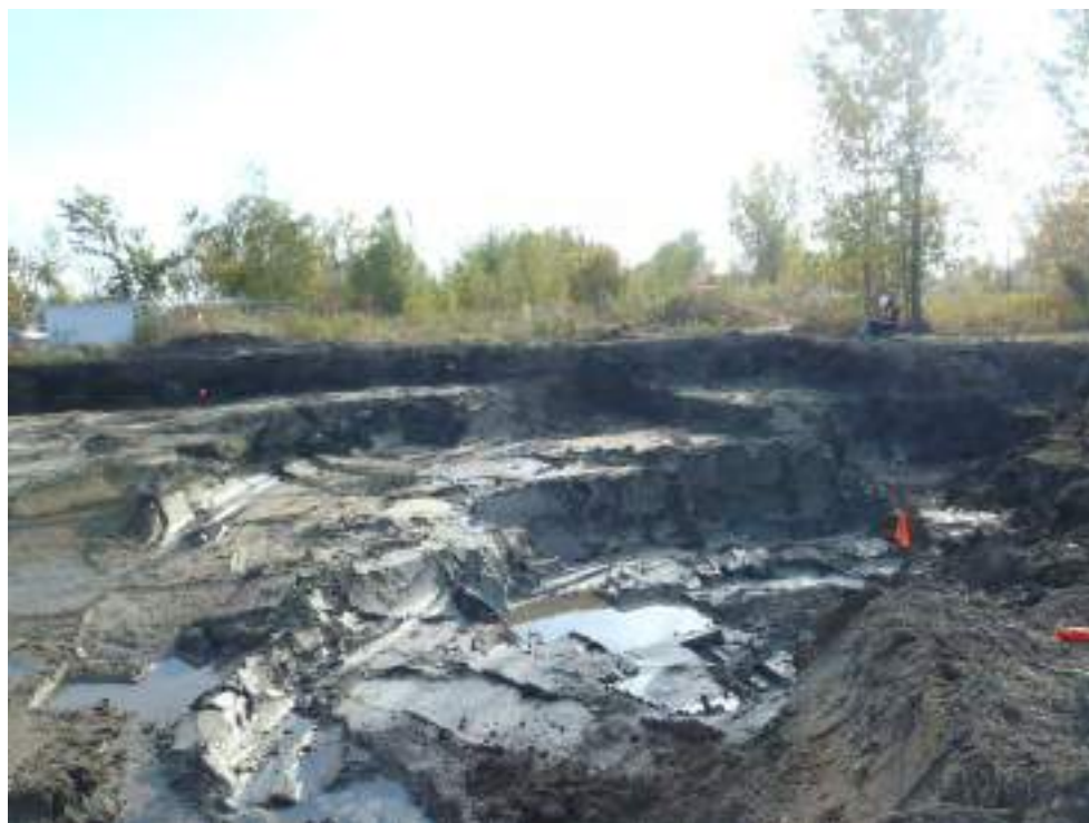
Photo 11 : Zone B - Vue vers le sud de l'excavation B2.
