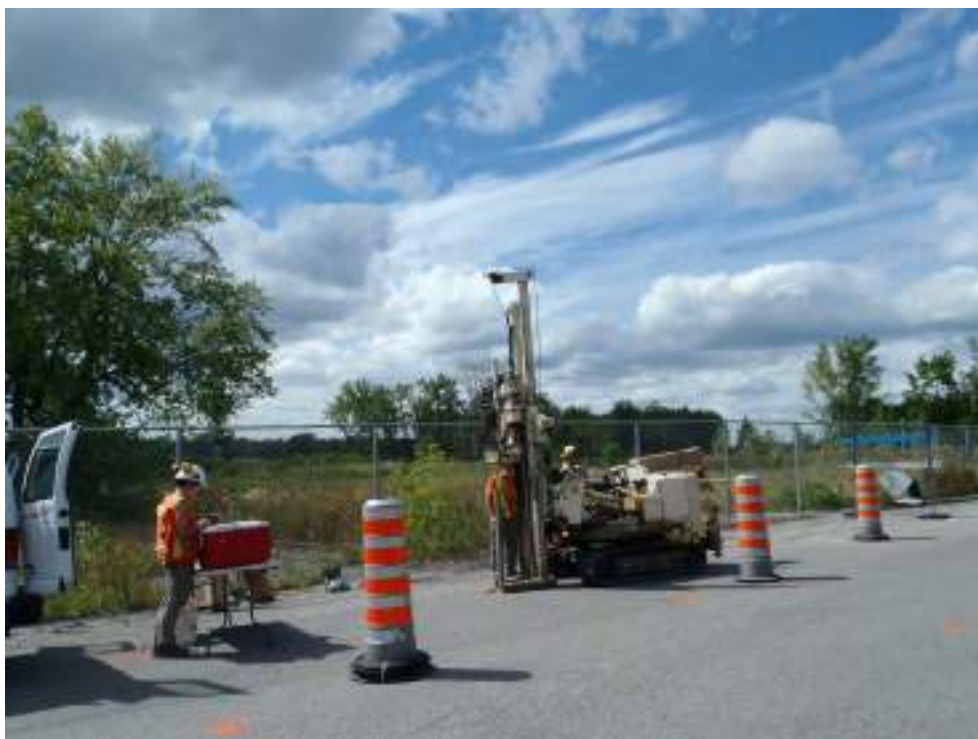
Photo 46 : Zone de la rue Purvis Club – Forages lors de la caractérisation complémentaire.
