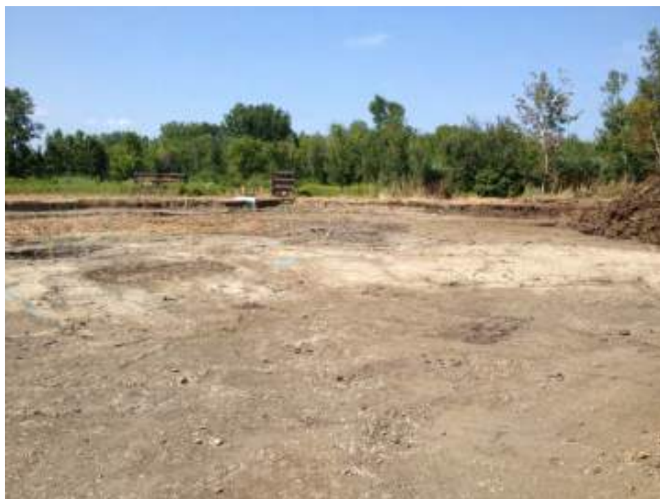
Photo 26 : Zone C - Vue vers le nord des excavations C1, C4 et C5.
