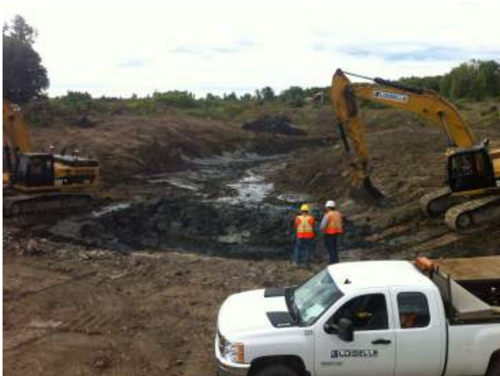
Photo 55 : Travaux de colmatage de l'extrémité amont du tronçon du ruisseau abandonné.
