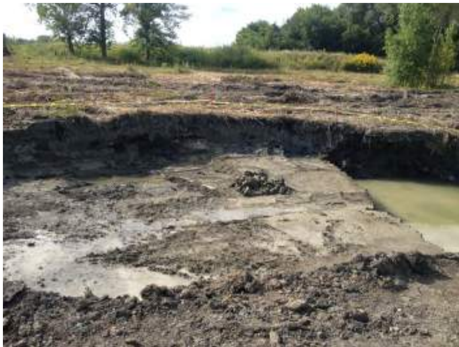
Photo 43 : Zone E - Vue vers le nord-ouest des excavations E1 et E2 (partie inondée).
