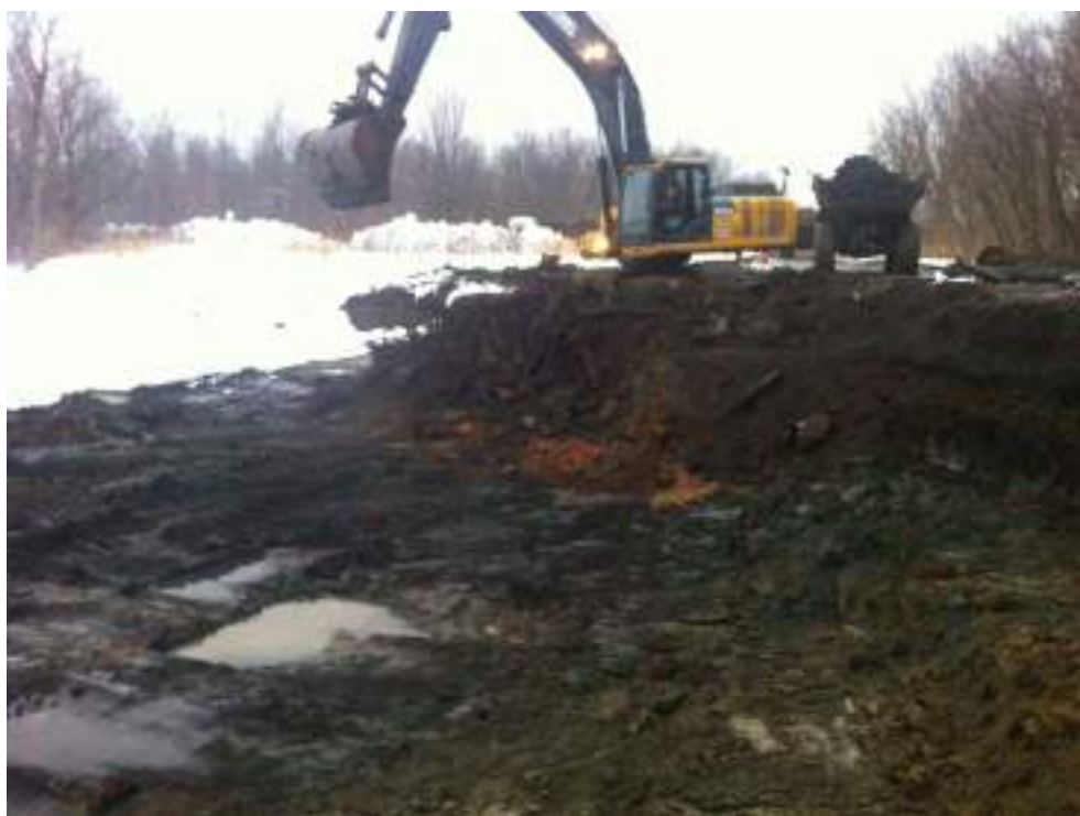
Photo 29 : Zone C11 - Vue de l'excavation C11.
