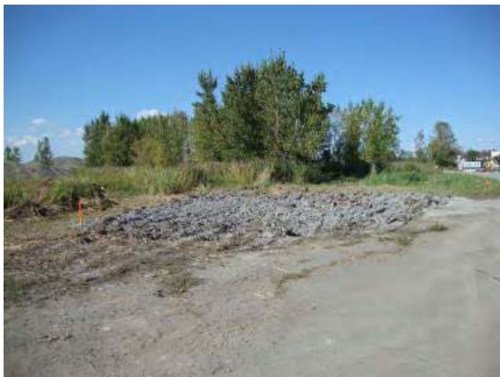
Photo 22 : Zone B - Vue de l'aire de traitement B13, une fois la chaux mélangée aux sols.
