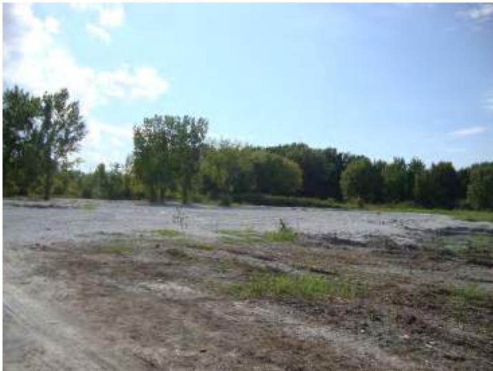
Photo 18 : Zone B - Vue de l'aire de traitement B9, une fois la chaux mélangée aux sols.
