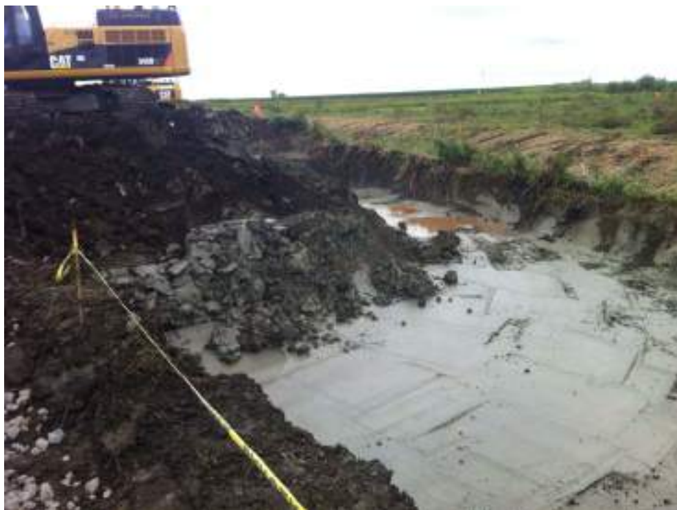
Photo 39 : Zone D - Vue de l'excavation D10.
