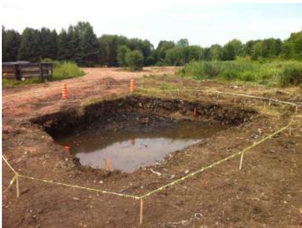
Photo 28 : Zone C - Vue de l'excavation C8.
