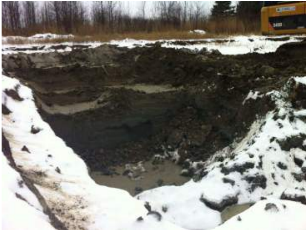
Photo 31 : Zone C - Vue de l'excavation C15.
