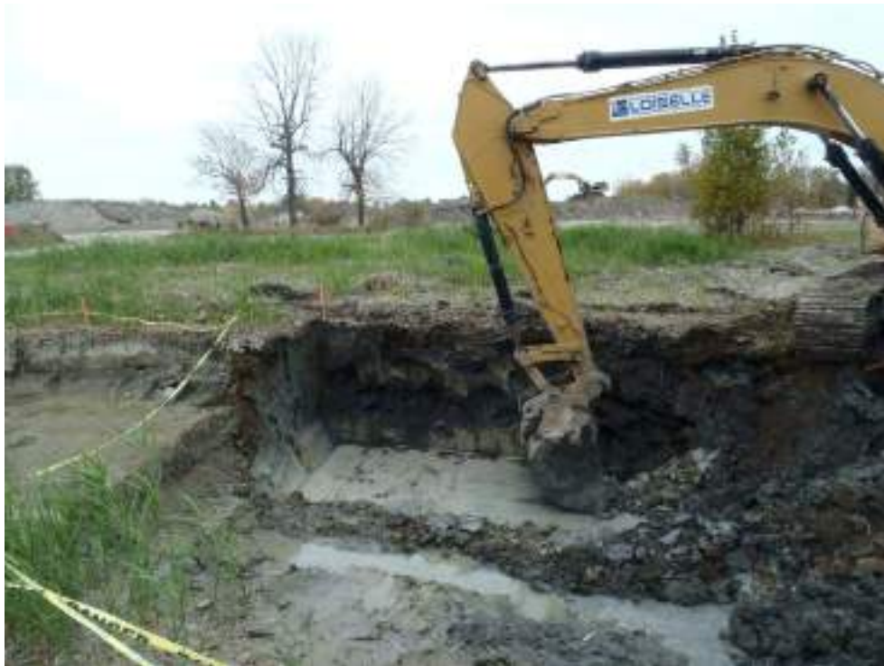
Photo 45 : Zone E - Vue vers l'ouest de l'excavation E2.
