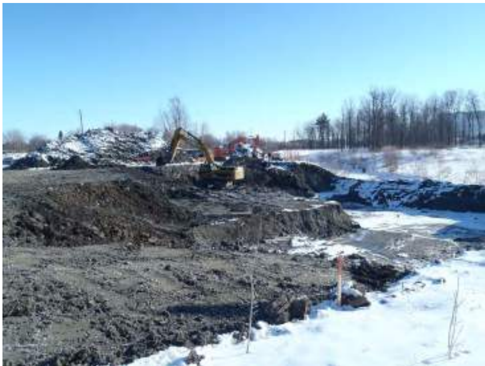
Photo 2 : Zone A - Vue vers le nord de l'excavation A1.
