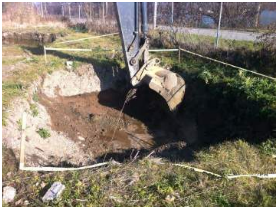
Photo 21 : Zone B - Vue vers l'est de l'excavation B12.
