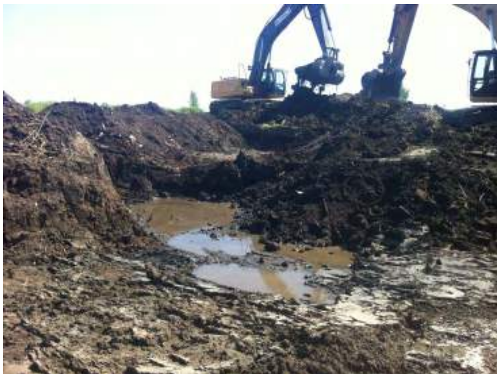
Photo 37 : Zone D - Vue de l'excavation D7.
