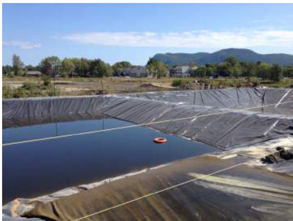
Photo 54 : Vue des bassins de sédimentation utilisés pour l'entreposage temporaire de l'eau de l'ancien ruisseau.
