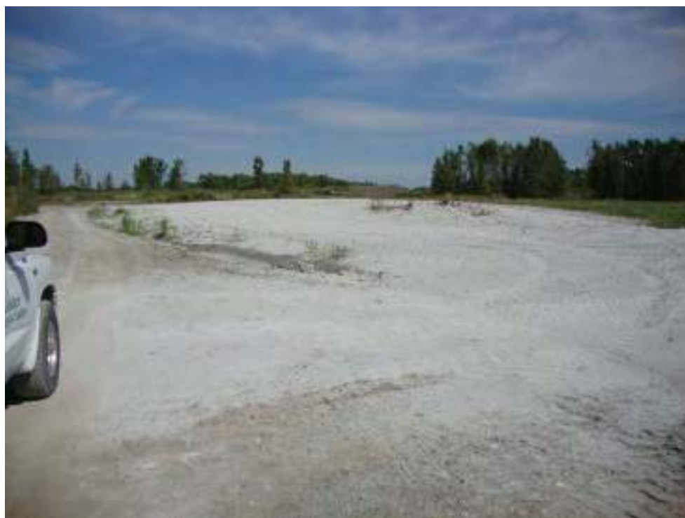
Photo 23 : Zone B - Vue de l'aire de traitement B14 suite à l'épandage de chaux.
