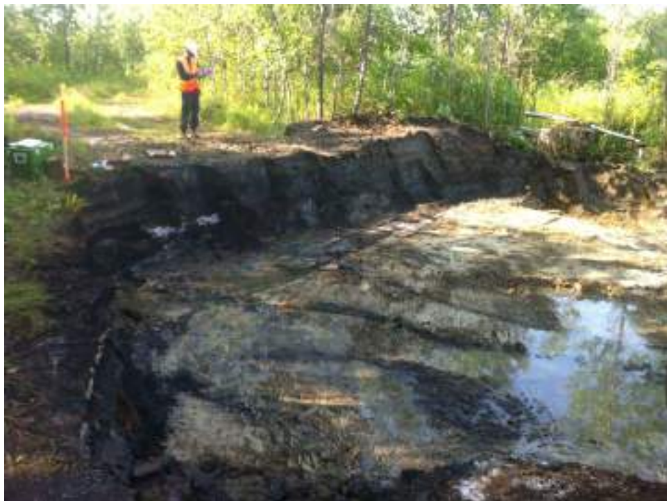
Photo 20 : Zone B - Vue de l'excavation B11.
