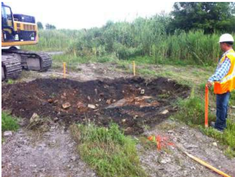
Photo 51 : Zone F - Vue vers le nord-ouest de l'excavation F5.
