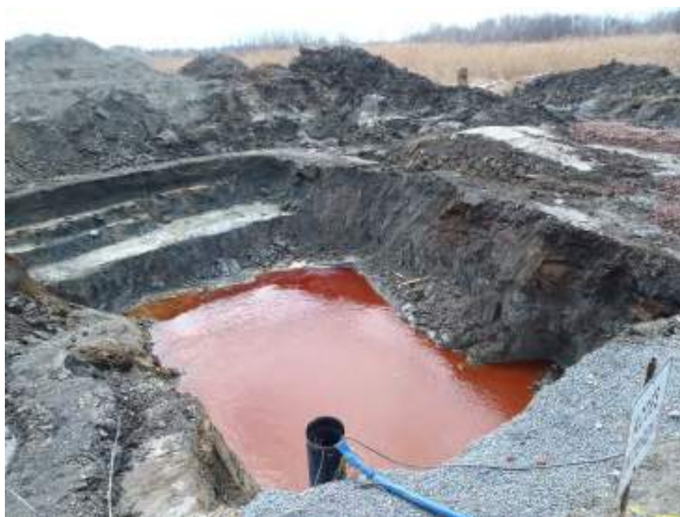
Photo 5 : Zone A - Vue vers le sud-est de l'excavation A4.
