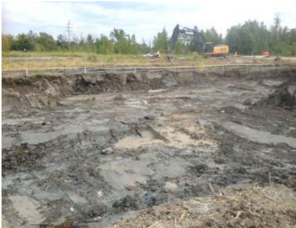
Photo 13 : Zone B - Vue vers le sud-est de l'excavation B4.
