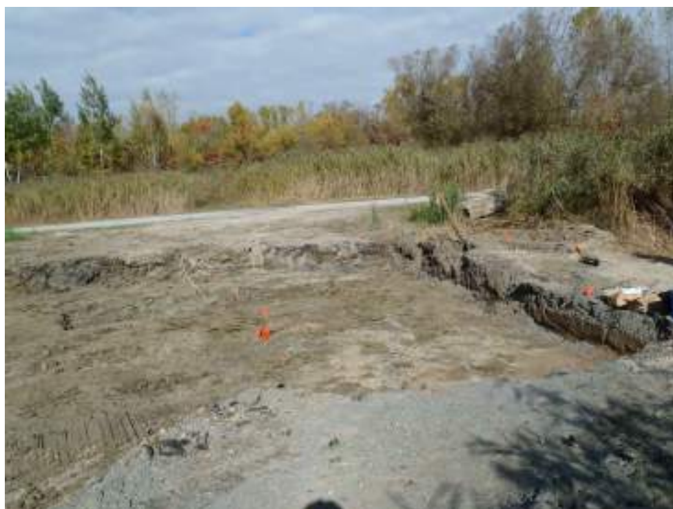
Photo 53 : Zone F - Vue vers le nord-ouest de l'excavation F7.
