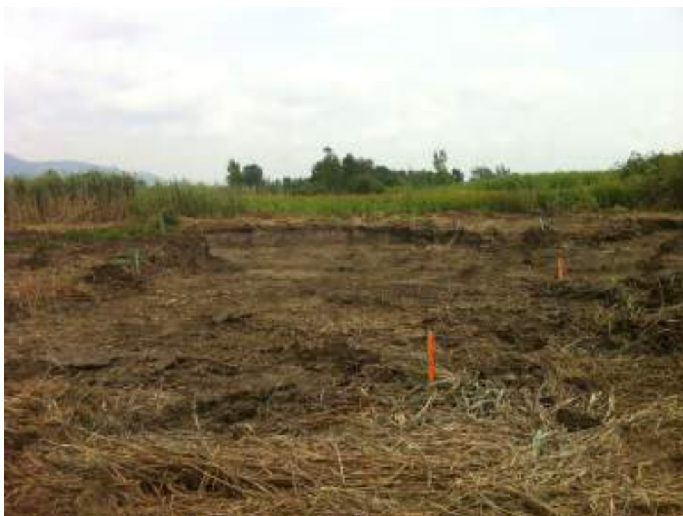
Photo 38 : Zone D - Vue de l'excavation D9.
