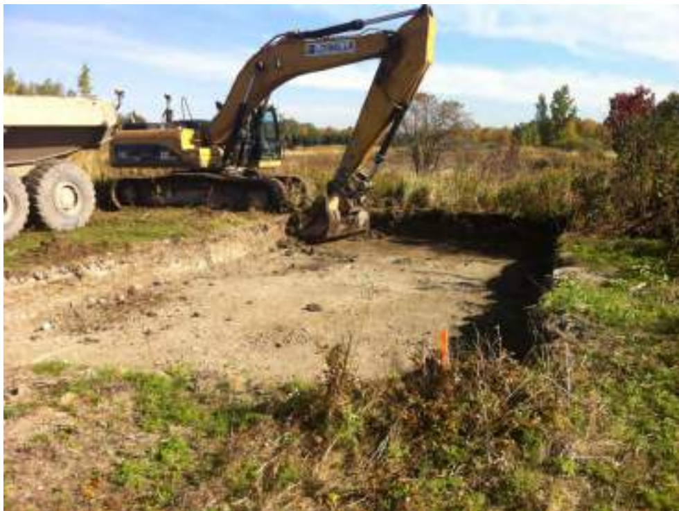
Photo 48 : Zone F - Vue vers l'ouest de l'excavation F1.
