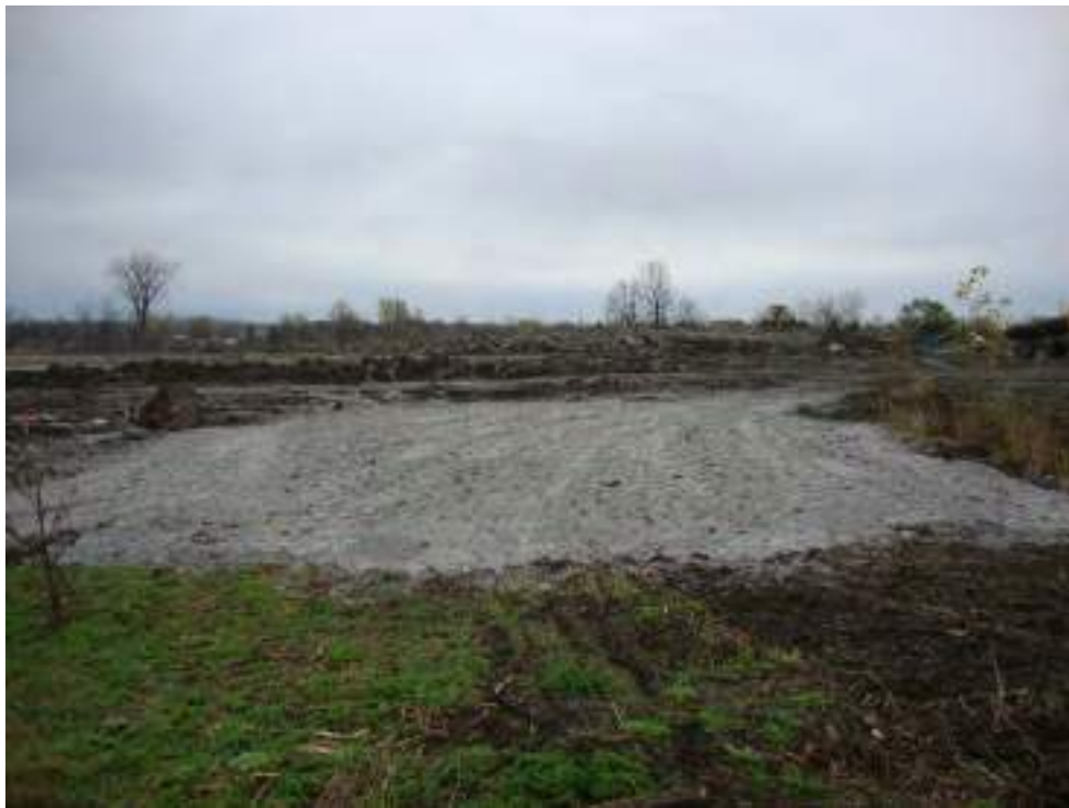
Photo 7 : Zone A - Vue de l'aire de traitement in-situ A5, une fois le mélange des sols et de la chaux complété.
