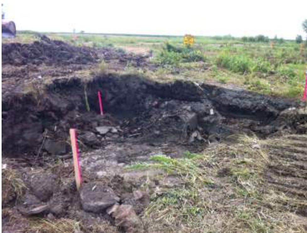
Photo 42 : Zone D - Vue de l'excavation D13.
