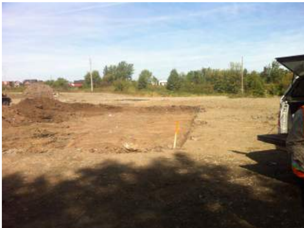
Photo 10 : Zone A - Vue de l'excavation A8
