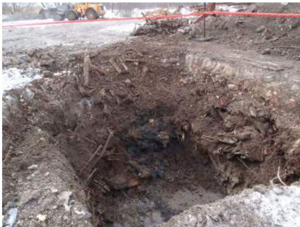
Photo 3 : Zone A - Vue vers l'est de l'excavation A2.
