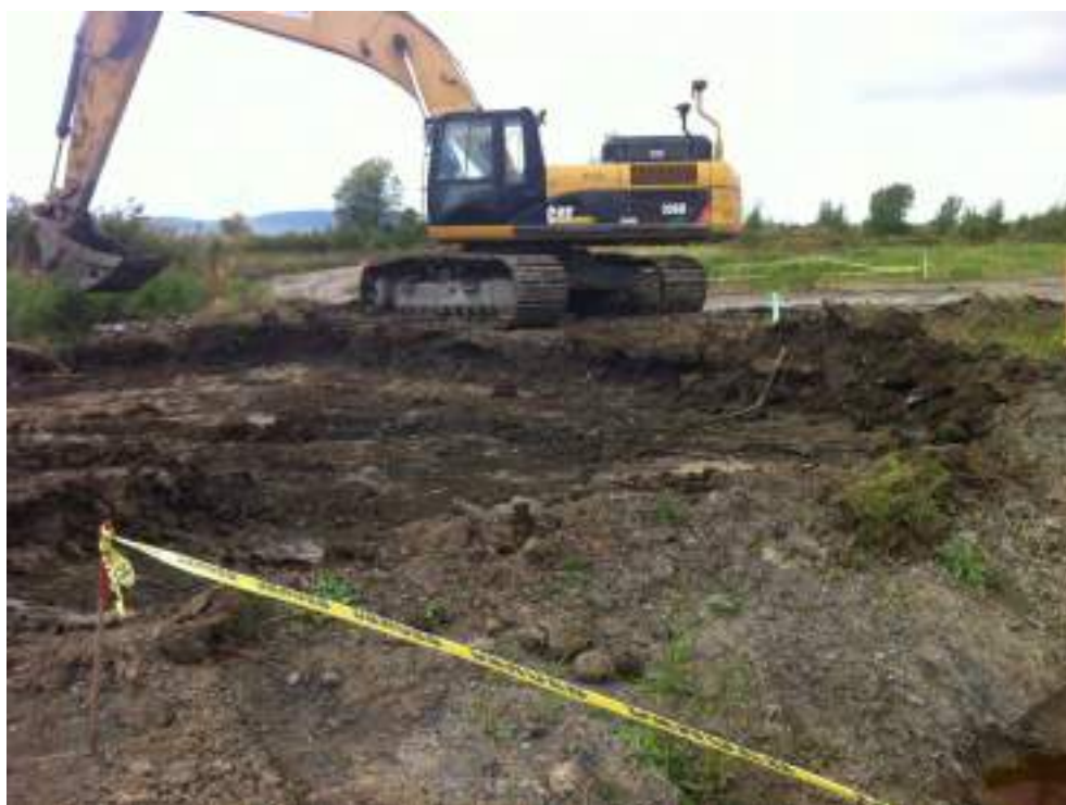
Photo 36 : Zone D - Vue de l'excavation D5.
