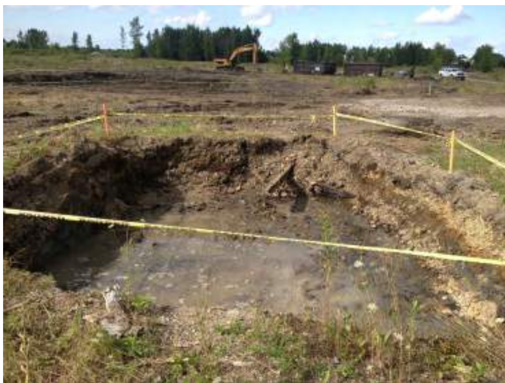
Photo 16 : Zone B - Vue vers le nord de l'excavation B7.
