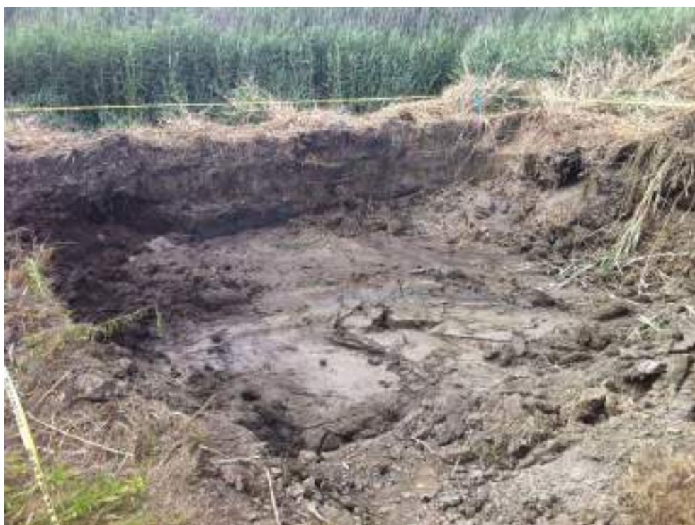
Photo 34 : Zone D - Vue de l'excavation D3.
