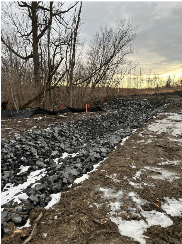
Figure 5 Fossé enroché vers l'exutoire au ruisseau
