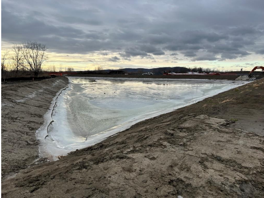
Figure 2 Bassin DS1, vu de l'extrémité sud
