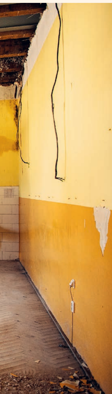
Tornádem poničená základní škola v Moravské Nové Vsi
