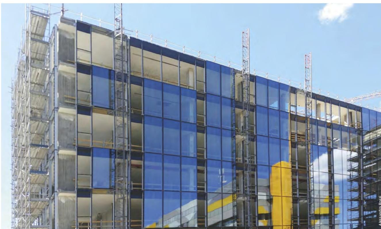
Fase di installazione dei profili a montanti e traversi della facciata vetrata. I montanti sono connessi con i solai ai vari piani attraverso piastre di acciaio
