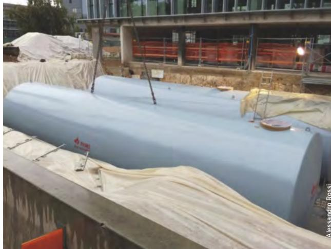
Posizionamento delle due cisterne per il recupero delle acque meteoriche
