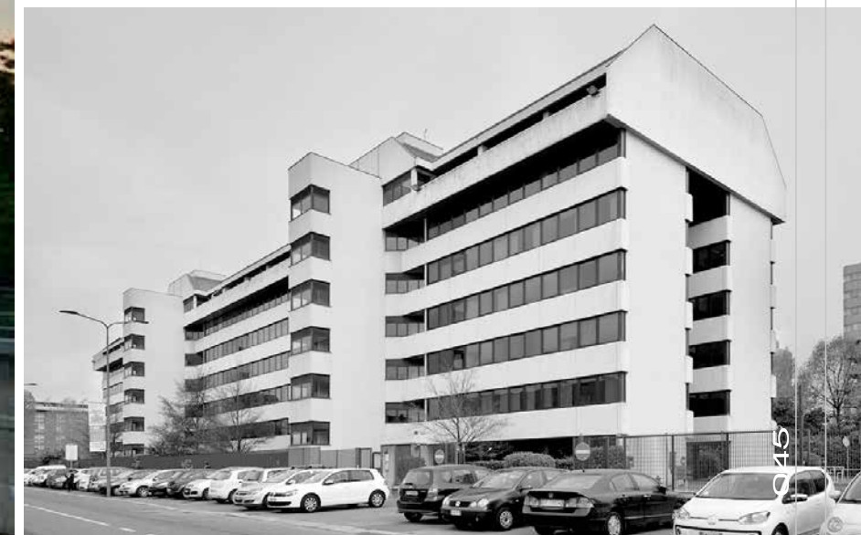
■ Vista dell'edificio prima dell'intervento
