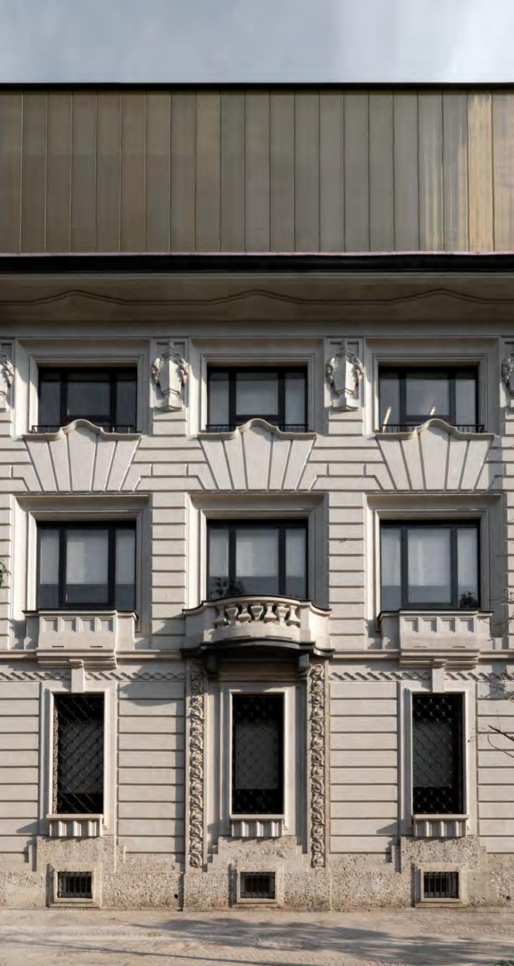
**IL PIANO AGGIUNTO SULL'EDIFICIO BASSO SI DISTACCA PER STILE DA ENTRAMBI GLI EDIFICI, SOTTOLINEANDONE LA DIVERSA EPOCA STORICA. PER IL SUO INVOLUCRO VETRATO SI È OPTATO PER UNA RETE METALLICA TRA LE DUE CAMERE, OTTONATA ALL'ESTERNO E NERA VERSO L'INTERNO CHE NE OPACIZZA LA SUPERFICIE MA LO RENDE SINTONICO CON I MATERIALI CIRCOSTANTI E AL TEMPO STESSO PROTEGGE DAL SOLE.**
