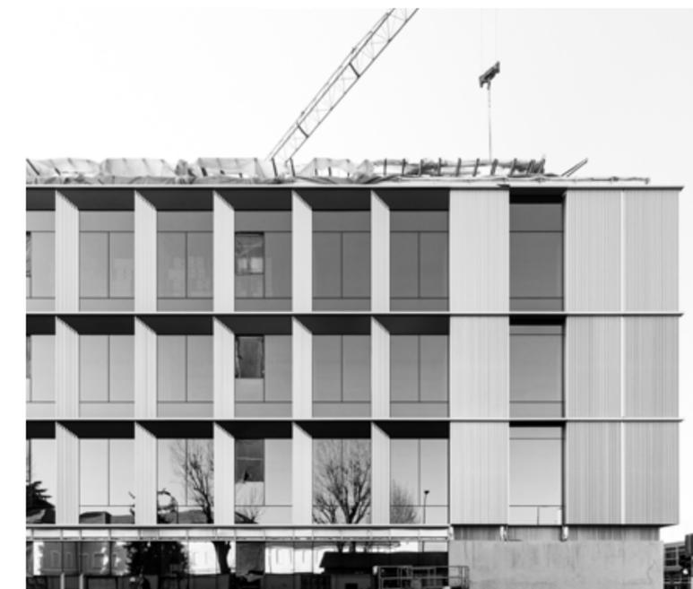
La fibra di carbonio usata per le strutture e il laminam, composto da due strati di ceramica molto sottili ma estremamente resistenti, per ricoprire la facciata a piano terra, sono altri elementi di innovazione nei materiali che concorrono alla leggerezza e versatilità dell'edificio.
