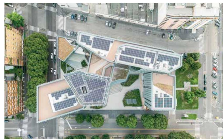
L'elevata performance energetica dell'edificio è ottenuta attraverso gli impianti di generazione e ventilazione integrati con gli impianti di illuminazione a led e con sistemi di controllo volti a massimizzare il comfort riducendo gli sprechi di energia. È inoltre presente un impianto fotovoltaico in copertura che contribuisce a diminuire il fabbisogno di energia elettrica dalla rete. Foto ©Nicola Colella, Park Associati.
