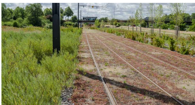
Aménagements paysagers le long de la voie à Grigny
