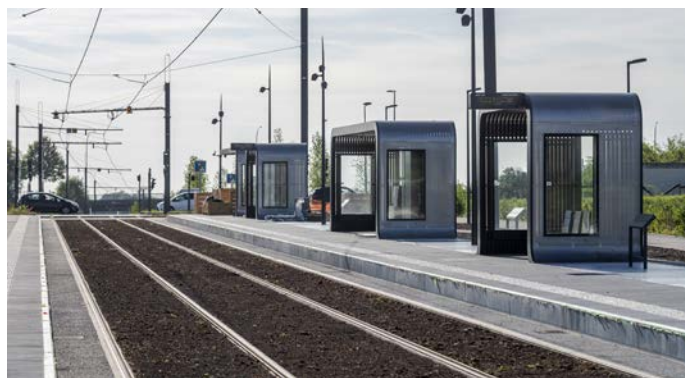
Aménagement de la station Ferme Neuve à Grigny
