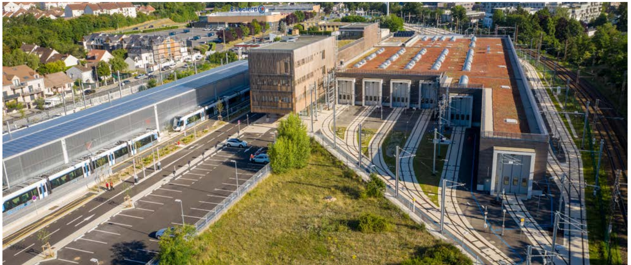
Atelier-Garage du tram-train T12 à Massy Palaiseau
