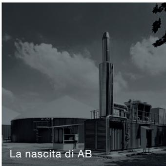
Negli anni '80 AB realizza impianti elettrici e di automazione per il contesto agricolo e zootecnico. Nel 1996, con la fondazione di AB Impianti, ha inizio la progettazione dell'innovativo sistema di cogenerazione e biogas ECOMAX®, che integra tutti i suoi componenti all'interno di un container.
