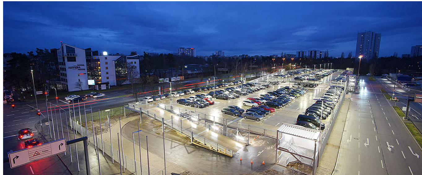
Abb. 25: Christmann + Pfeifer Construction GmbH & Co. KG, Parkhaus Nürnberg mit dem System Preflex® errichtet
