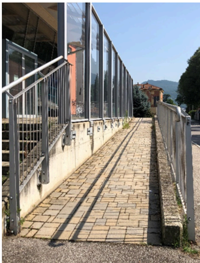
Rampa dell'ingresso principale
