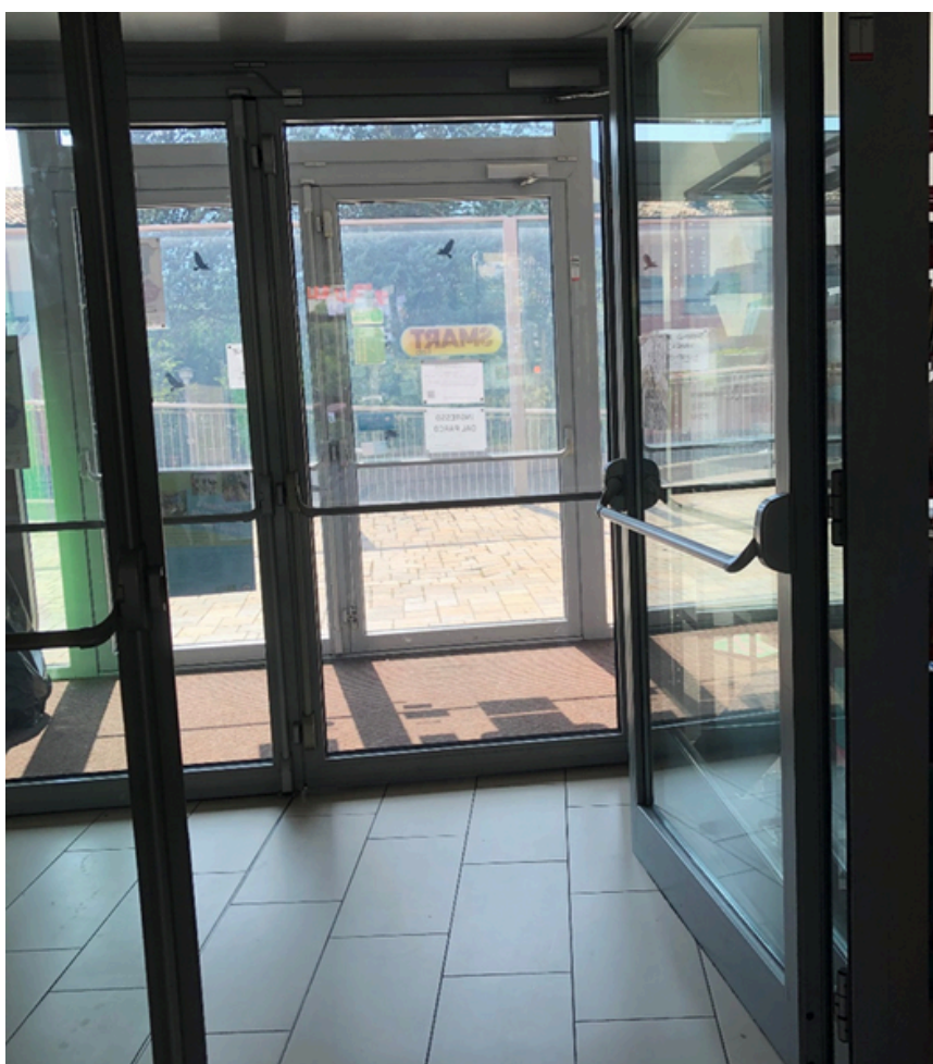
Panoramica interna dell'ingresso principale
