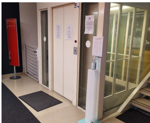
Ingresso interno dell'edificio
