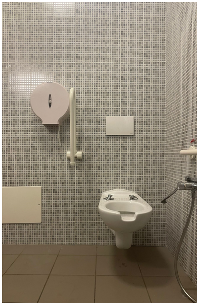
Panoramica dei servizi igienici (interno)
