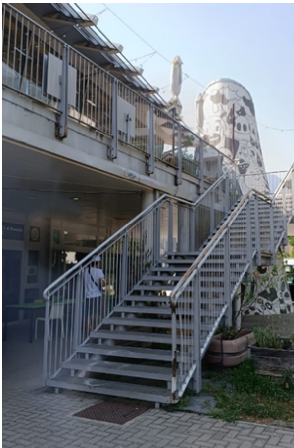
Ingresso dal retro con 24 scalini
