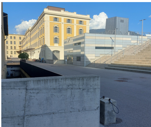
Passaggio tra Be Factory e bar
